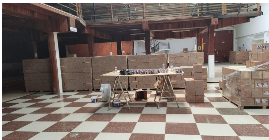
Figura 45b. Después de la etapa de limpieza.
