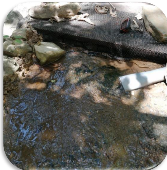
IMAGEN 3: Tubería de 2” funcionaba como red clandestina para riego de cultivo.
