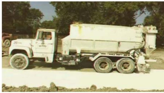
Figura 3. Estabilización Con Cal
