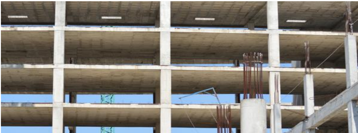
Figura 6. Sistema Aporticado de concreto armado
