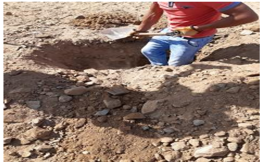
Foto 3.17 Comienzo de excavación Calicata 2
