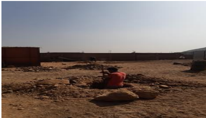
Foto 3.18 Comienzo de excavación Calicata 3
