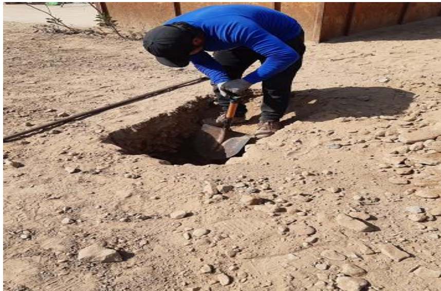
Foto 3.16 Comienzo de excavación Calicata 1
