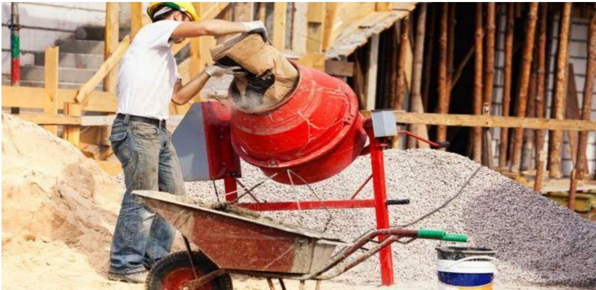
Figura 1. Mezcla de concreto
