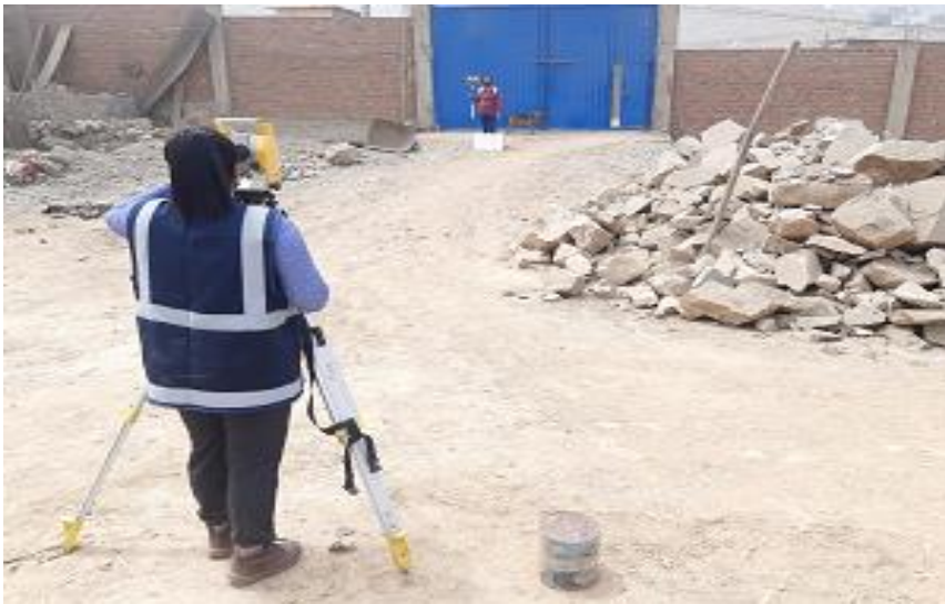
Foto 3.14 Término de levantamiento topográfico
