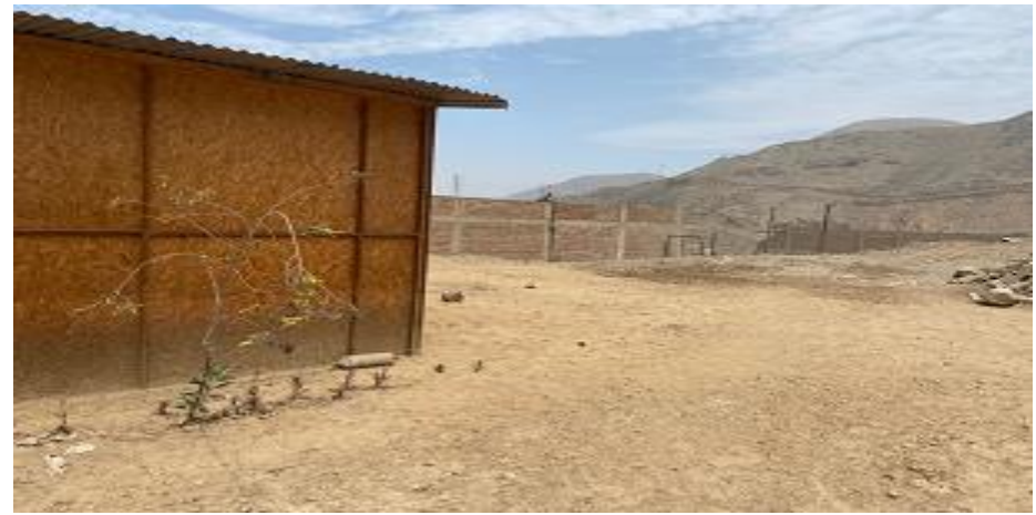
Foto 3.6 Vista panorámica izquierda del terreno
