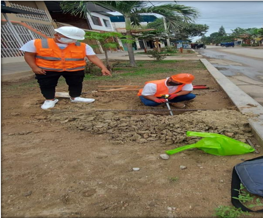
REALIZACIÓN DE LA CALICATA N°02
