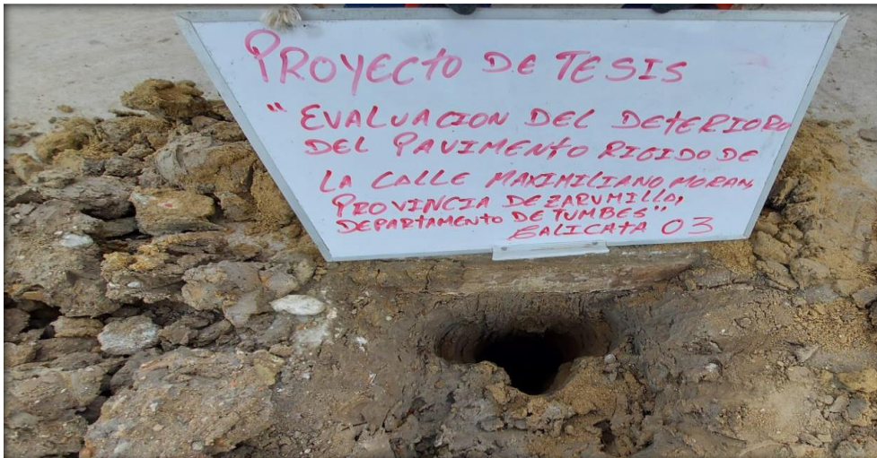
REALIZACIÓN DE LA CALICATA N°03
