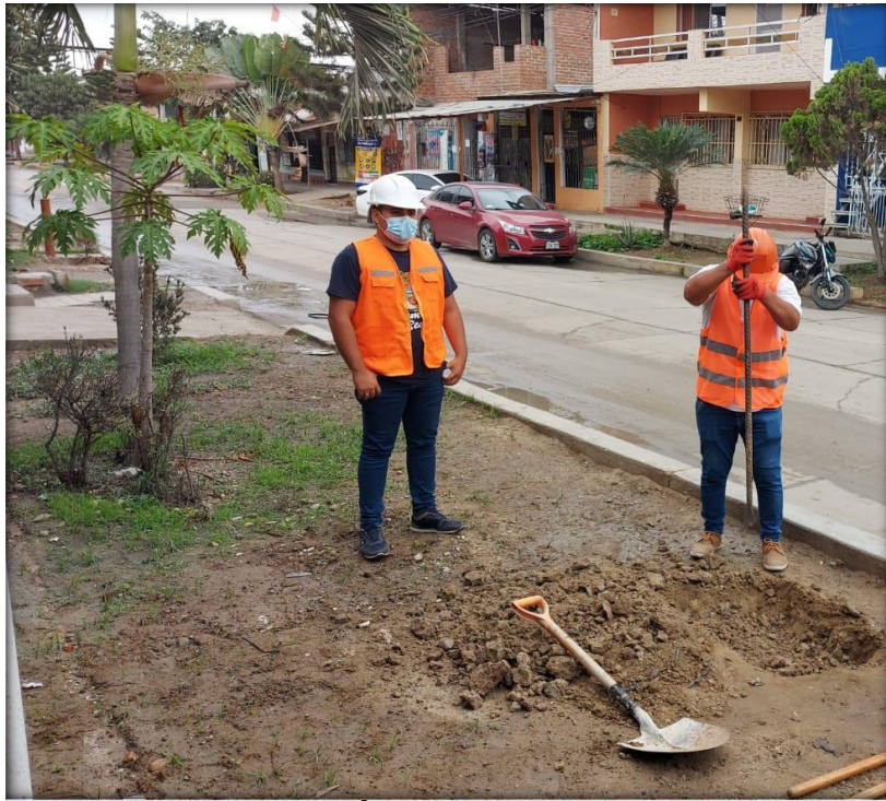
REALIZACIÓN DE CALICATA N°01
