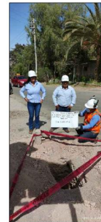
CALICATA C-1 PROG. 3+560
