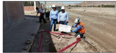
CALICATA C-3 PROG. 1+300
