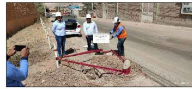
CALICATA C-2 PROG. 2+160
