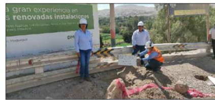
CALICATA C-4 PROG. 0+680
