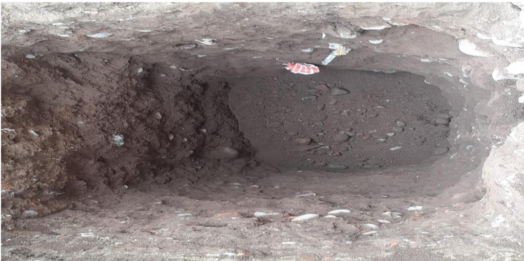
**Figura 19:** Excavación de la C – 02 con una profundidad de 1.50 m.
