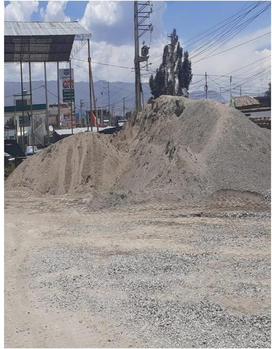
**Figura 27:** Acopio del agregado fino.
