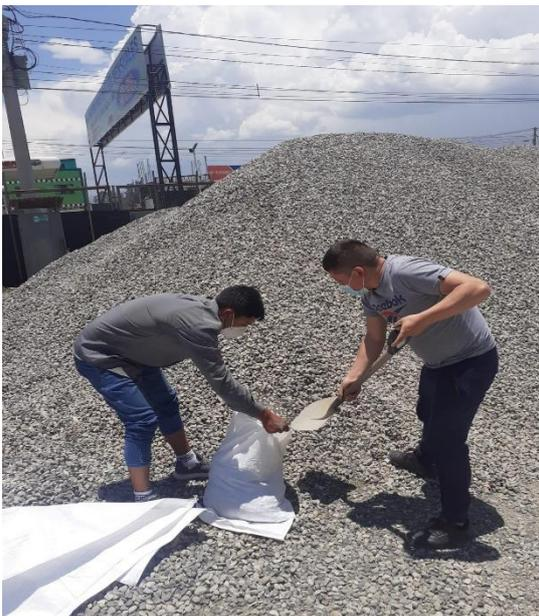
**Figura 28:** Embolsado del agregado grueso.
