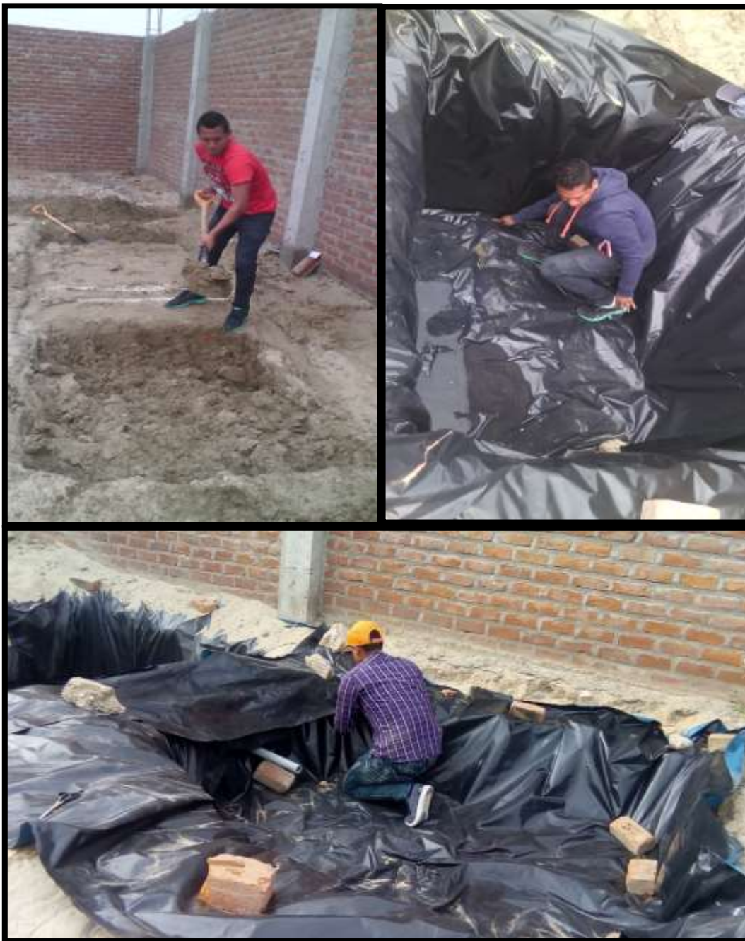
Figura18. Construcción de las dos lagunas pilotos del sistema fitorremediador
