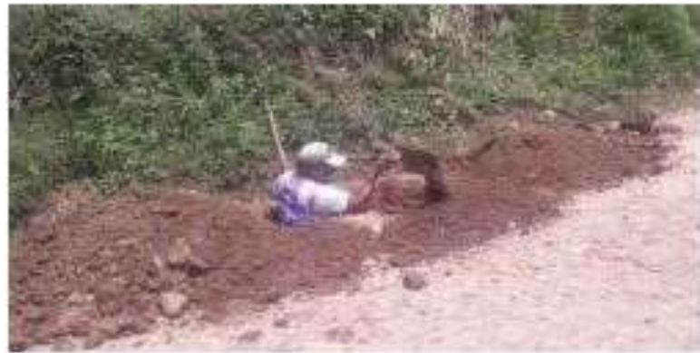
Foto 04: Excavación de calicata N°02 Km 2+00
