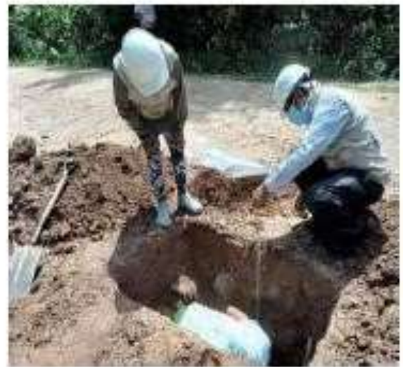
Foto 06: Midiendo la profundidad de la calicata (1.30 m)
