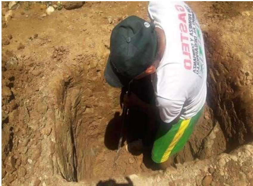
Ilustración 03: Excavación de calicata N°01
