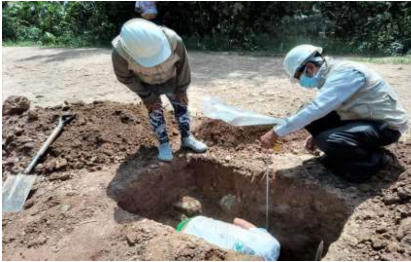
Ilustración 05: Midiendo la profundidad de la calicata (1.50m)
