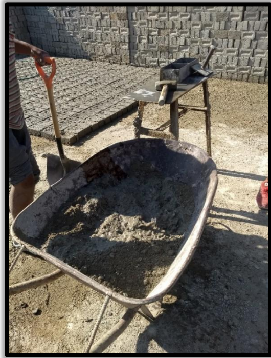
5. Dosificación con 50 gr de Cascara de Huevo. Pasos Agregamos la Cascara de Huevo y batimos
