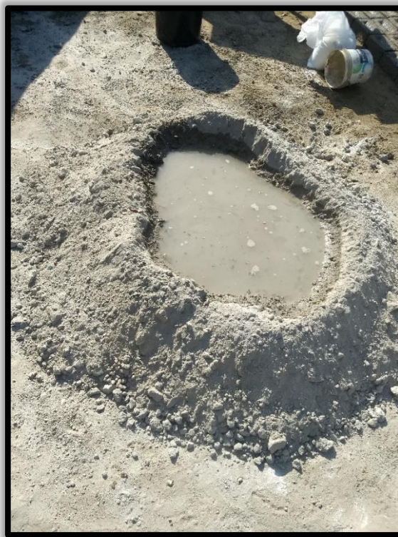
4. Para dosificación de Material de eliminación, cal, cemento, arena y agua.
