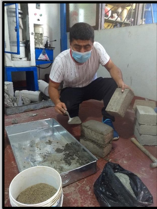
14. Apilado de los ladrillos con mortero.
