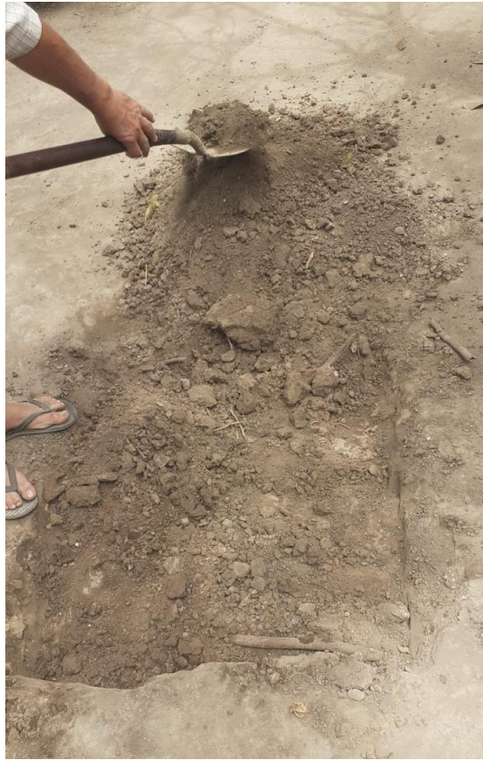
Foto N° 09: Ejecución de calicatas
