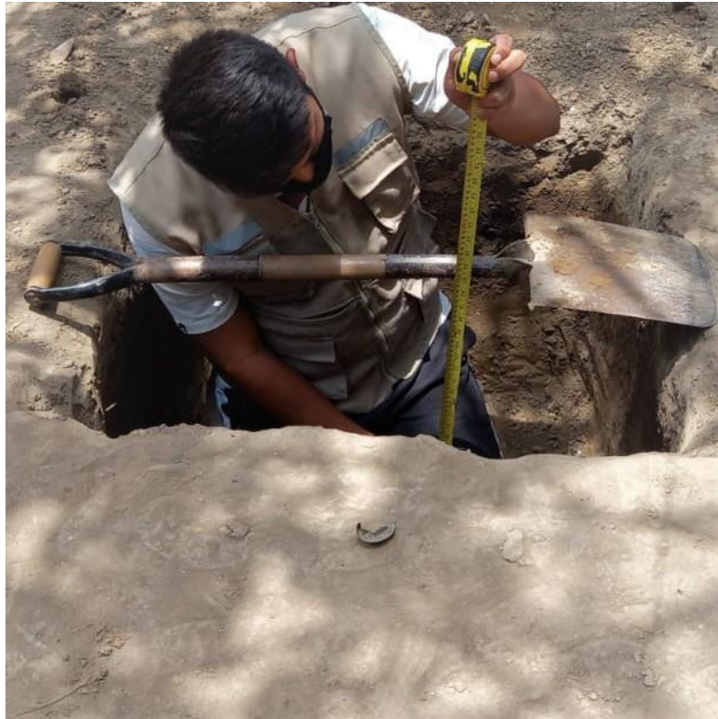
Foto N° 10: Ejecución de calicatas
