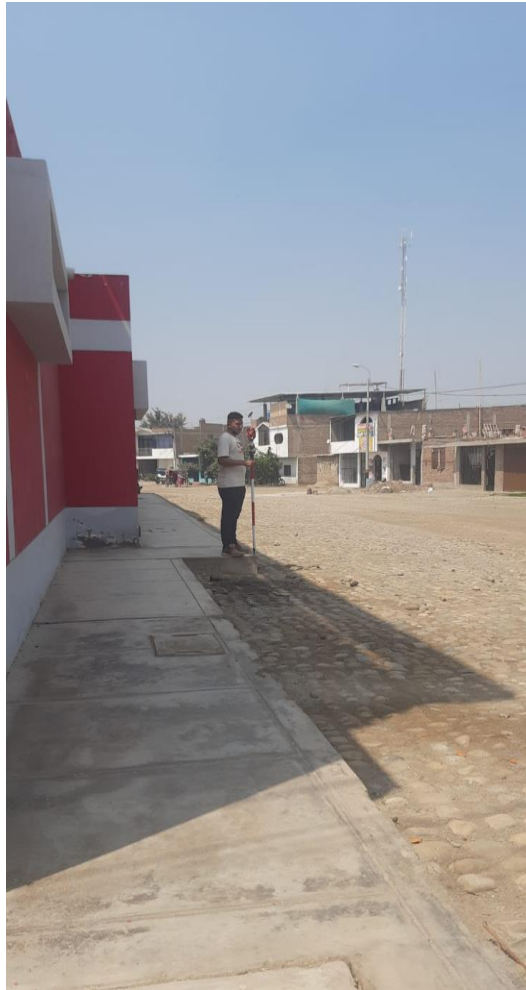
Foto N° 07: Toma de puntos para estudio topográfico
