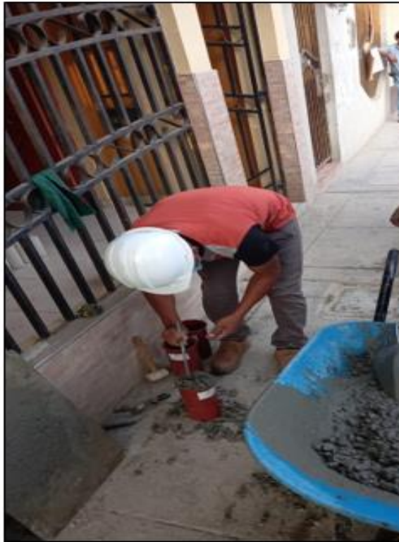
Elaboración de probetas de concreto modificado – F'c = 210 \text{ kg/cm}^2 con adición de fibras de acero.
