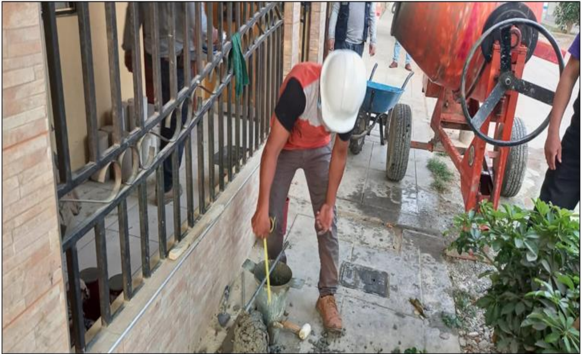
Tomando medida de slump del concreto patrón F'c = 210 \text{ kg/m}^2
