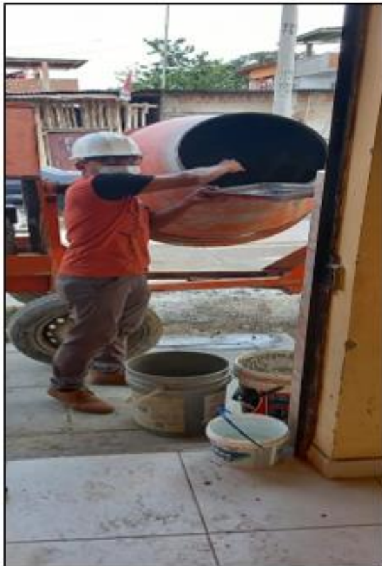
Mezclado del concreto
