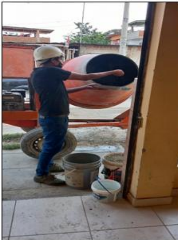
Mezclado del concreto.
