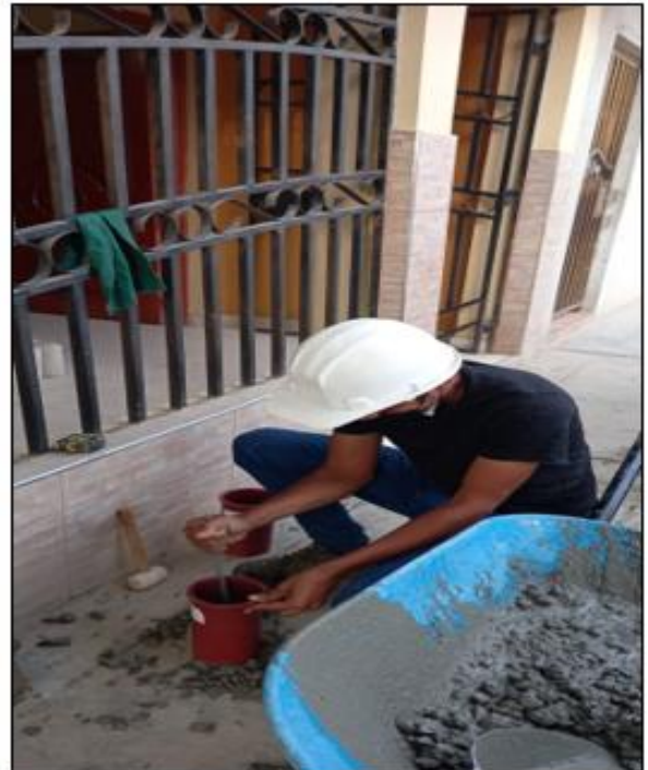
Elaboración de probetas de concreto modificado – F'c = 210 \text{ kg/cm}^2 con adición de fibras de acero.
