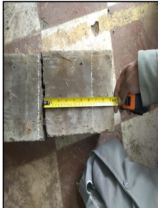
VISTA: TOMA DE DATOS DE FRACTURA EN VIGAS
