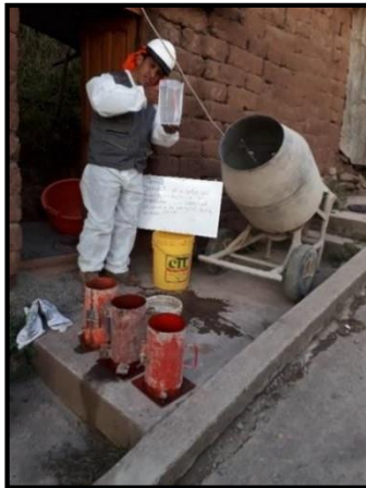
Figura N° 15: Preparación de concreto Fuente: Elaboración propia
