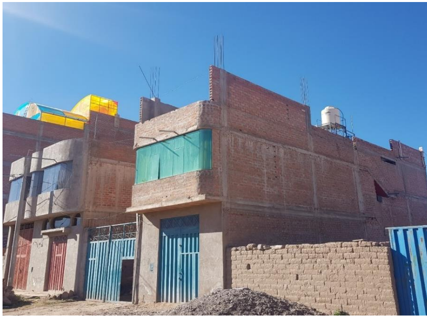
Figura 1.1: Viviendas construidas con ladrillo artesanal en la ciudad de Huancané
