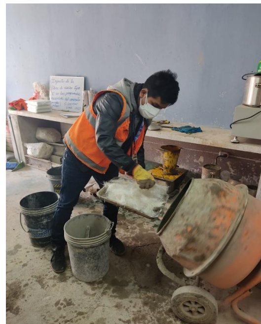
Foto N°11: Adición de los elementos que conforma el concreto, incluyendo la fibra de vidrio
