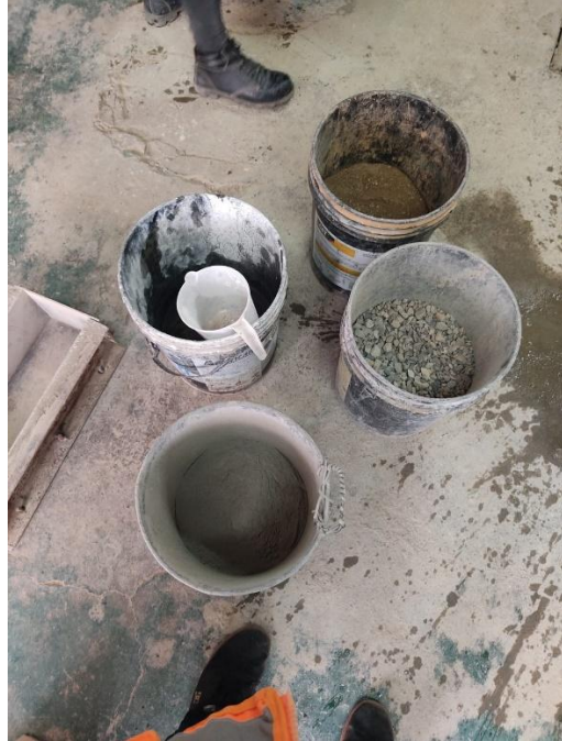
Foto N°06: Dosificación de los materiales para la mezcla del concreto
