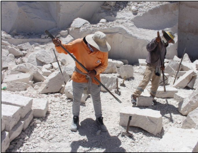
Figura 8. Fabricación de bloques de sillar para tabiquería.
