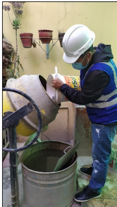
Figura 18. Procedimiento de mezcla del concreto experimental. Fuente: Fotografía propia.
