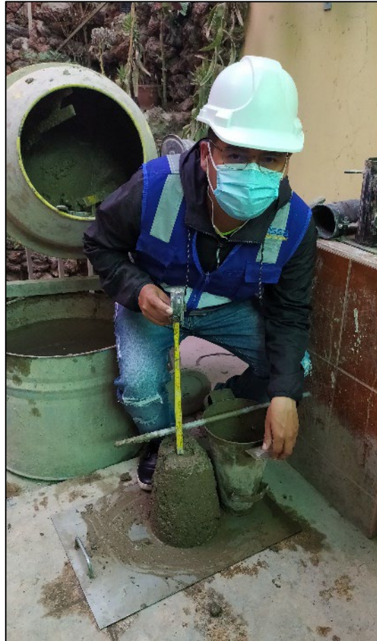
Figura 21. Realización del ensayo de asentamiento. Fuente: Fotografía propia.
