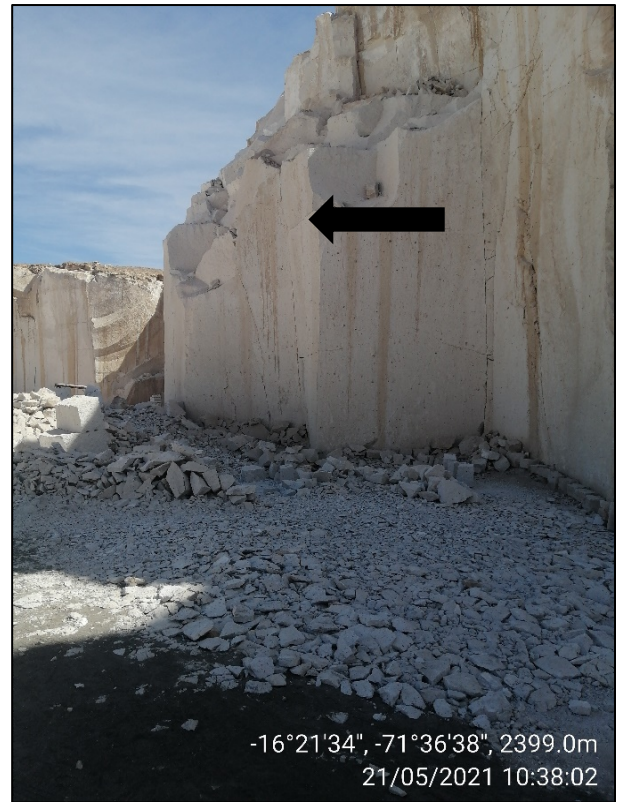
Figura 5. Huella en las paredes de la quebrada, luego de la extracción de los
