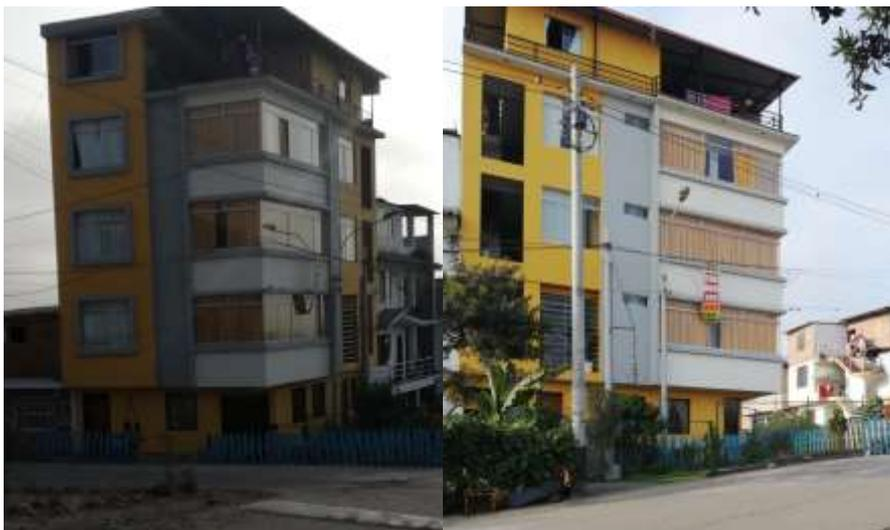
*Figura 7.* Viviendas de 5 niveles con albañilería confinada y armada
