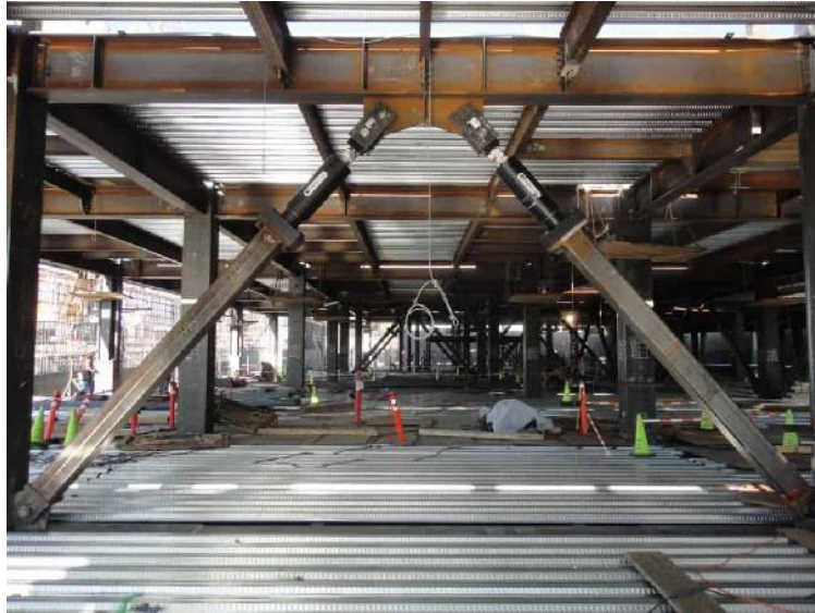
Figura 18. Configuración Chevron Brace
