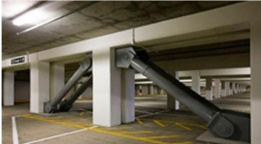
Figura 16. Configuración diagonal al interior
