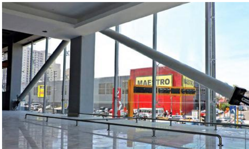
Figura 17. Configuración diagonal en fachada
