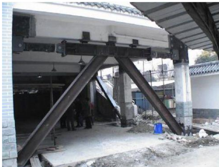
Figura 19. Configuración Chevron Brace - mejorada
