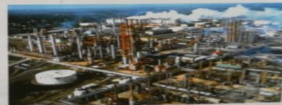
Refinería de petróleo en México.
