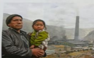
Chimenea del complejo metalúrgico de La Oroya, Junín.
