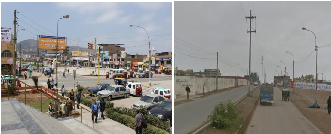
Figura 31: Estado de las avenidas principales de la zona de estudio Fuente: Elaboración propia
