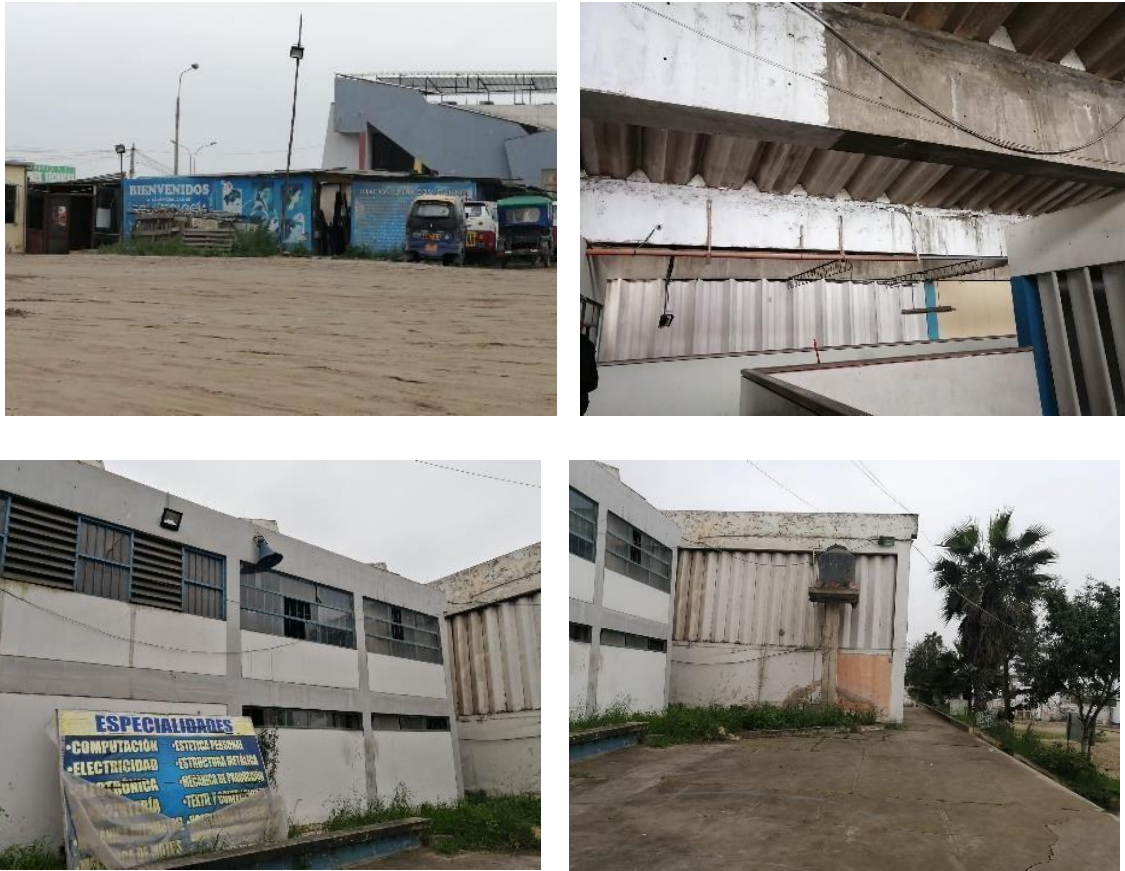
Figura 13: Infraestructura del CETPRO PROMAE
