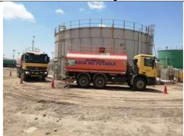
Recarga de agua de planta de potabilización de agua
