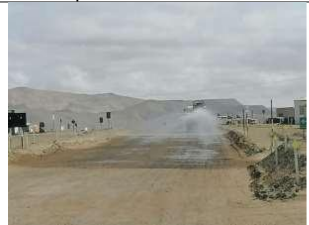
Aplicación de aditivo H4, cloruro de magnesio. Para control de polvo
