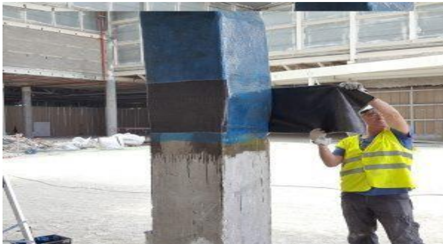
Figura 1 Reforzamiento estructural especial con láminas de fibra de carbono.
