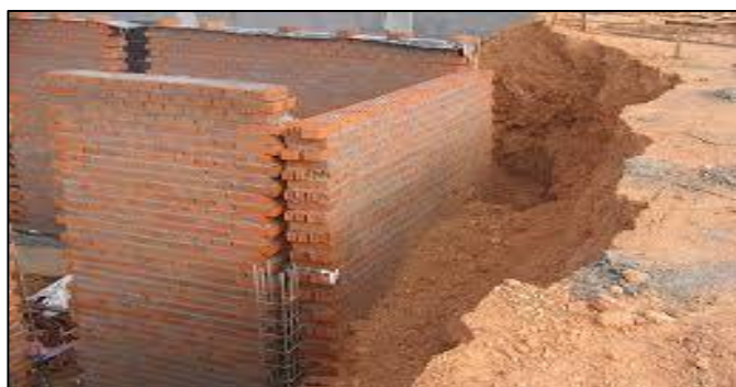
Figura 7 Muro de albañilería confinada
