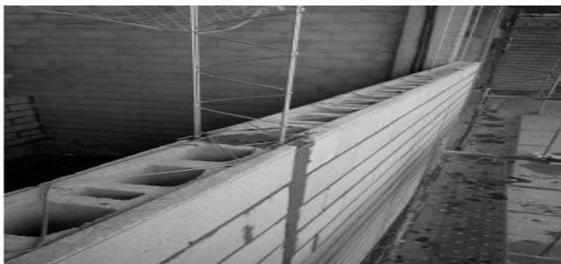
Figura 6 Muro de albañilería armada
