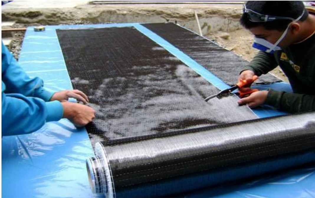
Figura 4 Acondicionamiento de láminas de fibra de carbono
