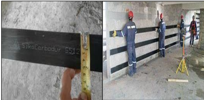
Figura 3 Reforzamiento de muros con láminas de fibra de carbono.
