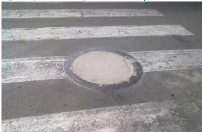
Figura 57, Buzón de desagüe del Sector Chequio
