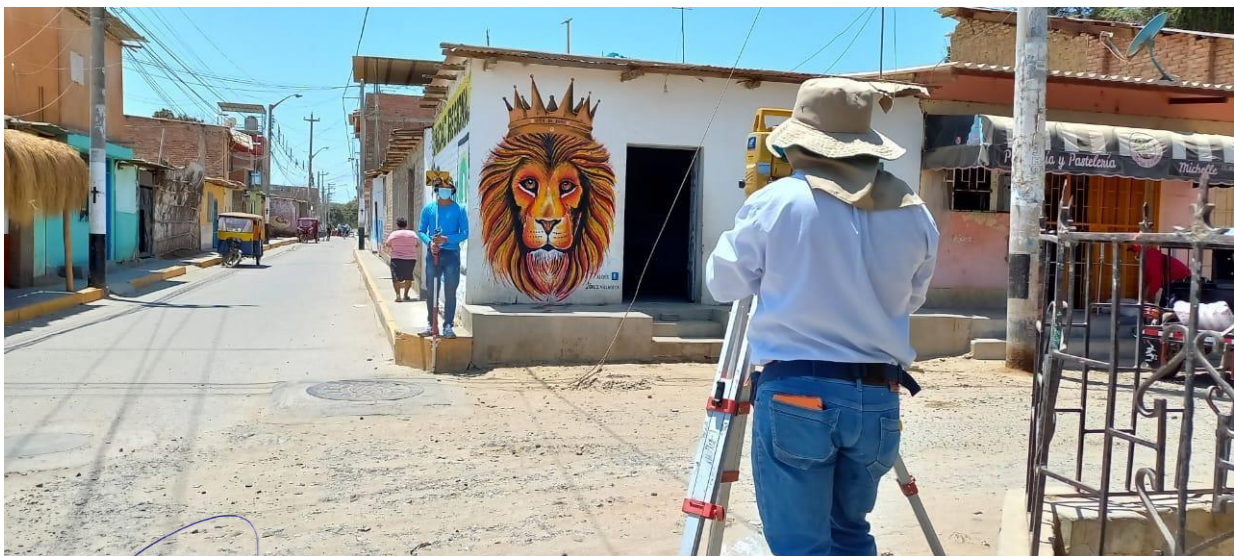
FOTO: TOMA DE PUNTOS CON ESTACION TOTAL DEL JIRÓN MARIANO DIAZ ENTRE LAS CALLES ICA Y PISCO
