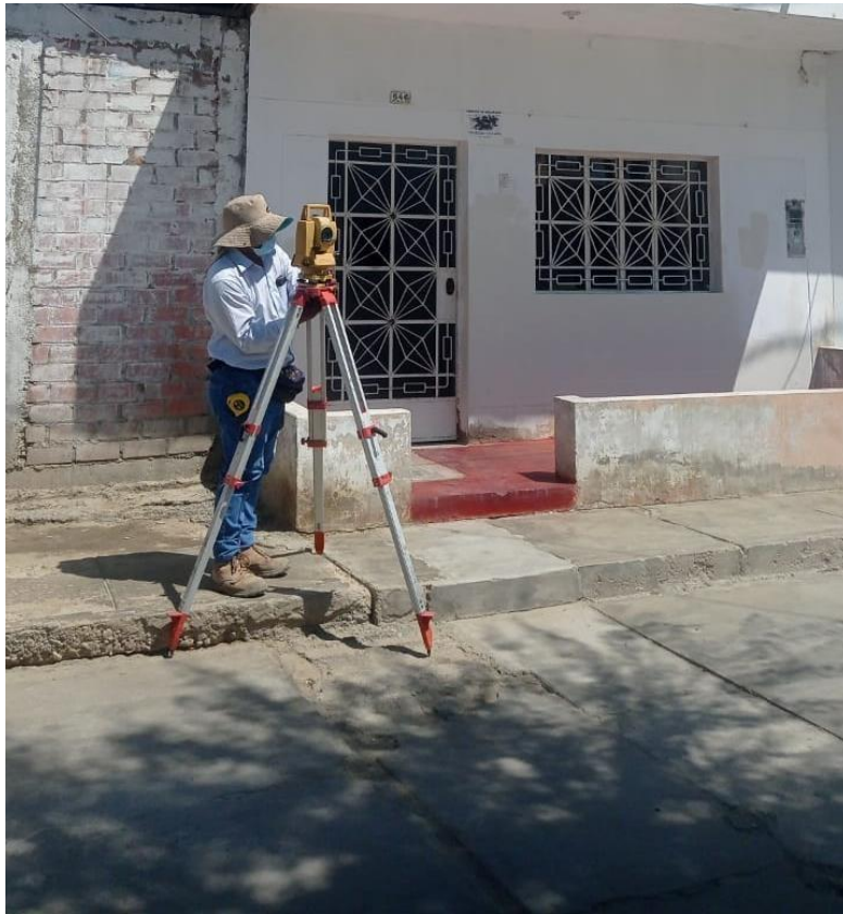
FOTO: TOMA DE PUNTOS CON ESTACION TOTAL DEL JIRÓN MARIANO DIAZ ENTRE LAS CALLES MOQUEGUA E INDEPENDENCIA
