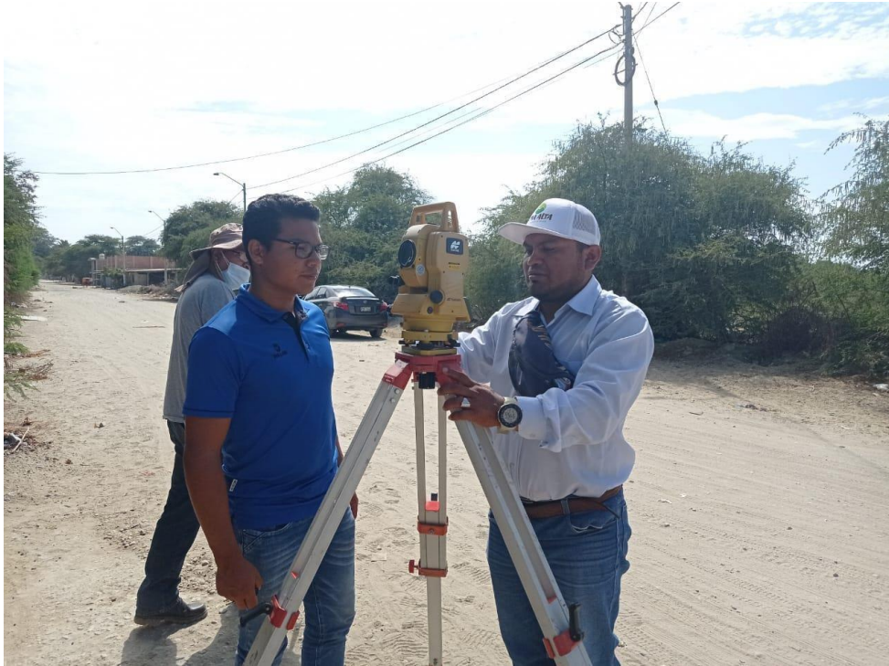
FOTO: INSTALACIÓN Y NIVELACIÓN DE ESTACIÓN TOTAL EN EL JIRÓN MARIANO DIAZ
