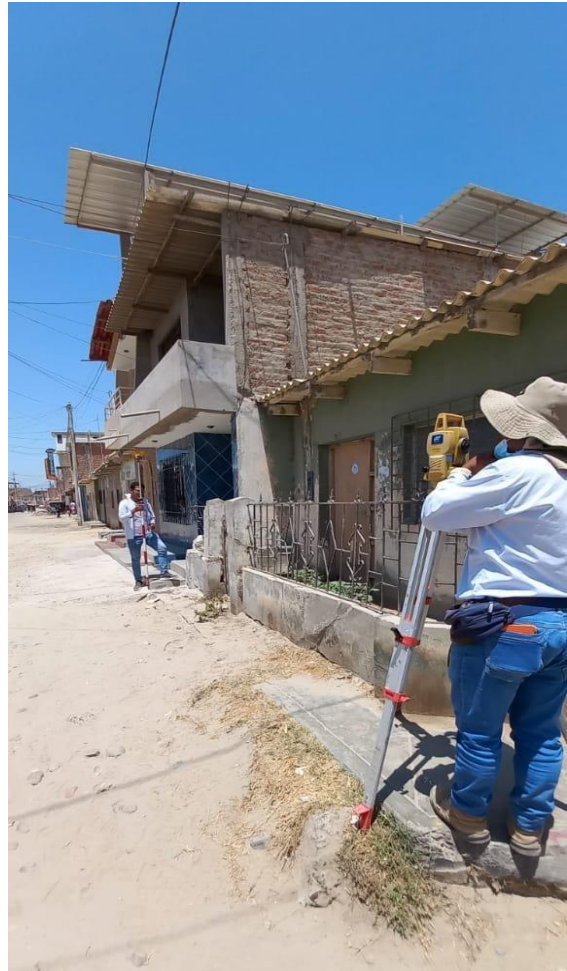
FOTO: TOMA DE PUNTOS CON ESTACION TOTAL DEL JIRÓN MARIANO DIAZ ENTRE LAS CALLES ICA Y PISCO
