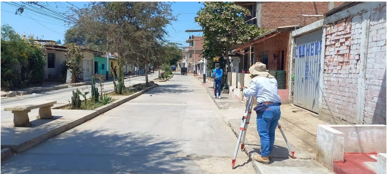
FOTO: TOMA DE PUNTOS CON ESTACION TOTAL DEL JIRÓN MARIANO DIAZ ENTRE LAS CALLES RAMÓN CASTILLA Y EL PUNTO DE INICIO DEL LEVANTAMIENTO TOPOGRÁFICO
