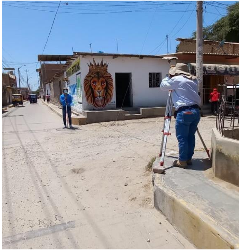
FOTO: TOMA DE PUNTOS CON ESTACION TOTAL DEL JIRÓN MARIANO DIAZ ENTRE LAS CALLES PISCO Y JUNIN
