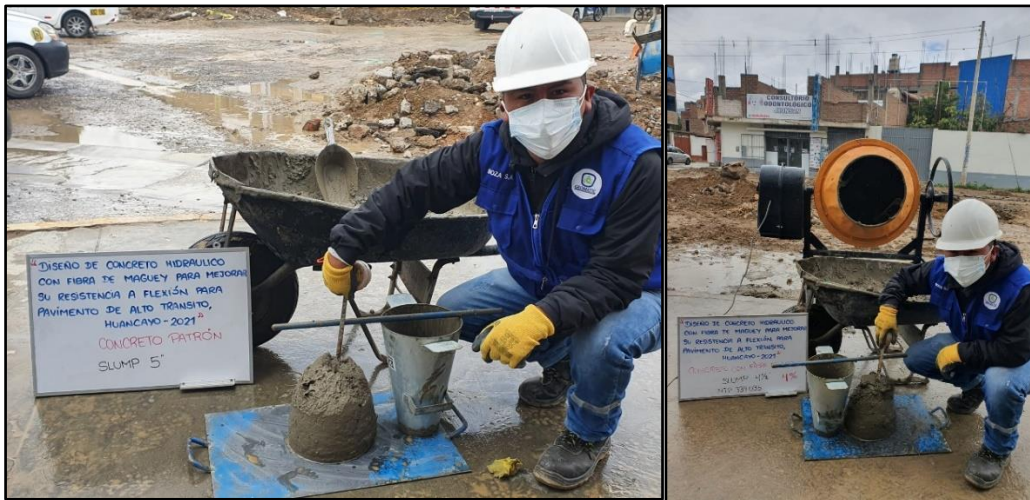
Figura 14: Procedimiento del ensayo de cono de abrams
