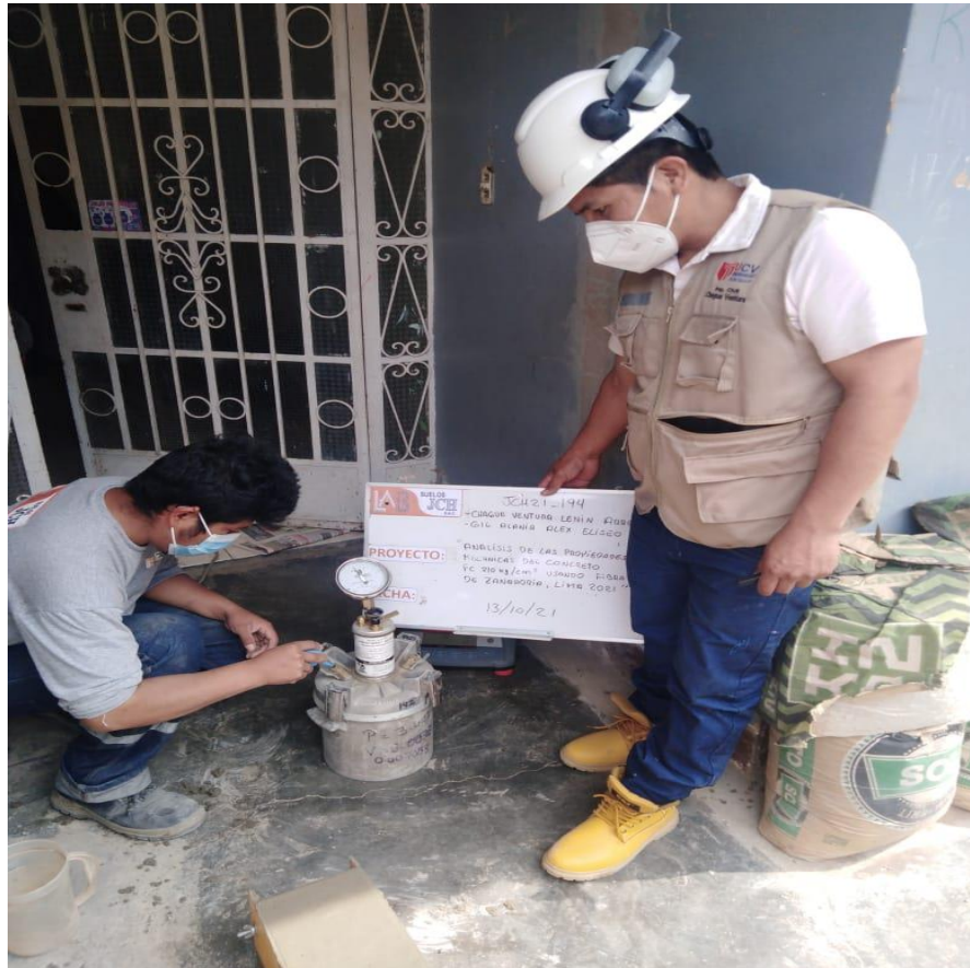
Ensayo de contenido de aire del concreto
