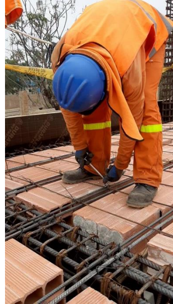
Figura 216: Armado de malla fina - D1 (2)
