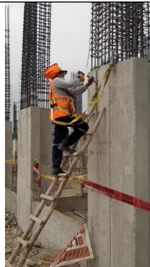
Figura 213: Picado de columnas - C1 (4)
