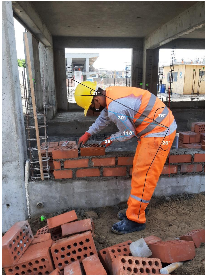
Figura 105: Asentado de ladrillo (RULA – T2), Consorcio Negrón, 2021.
