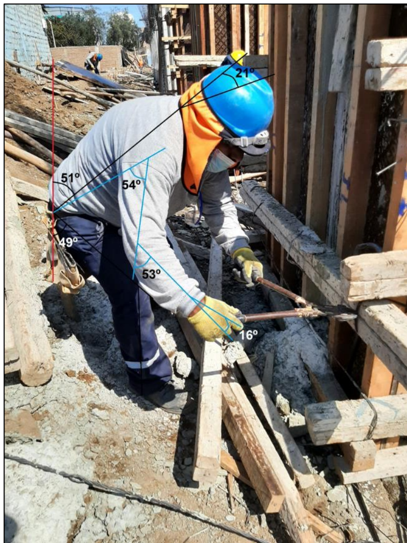
Figura 40: Desencofrado de columnas (RULA – T1), Consorcio Negrón, 2021.
