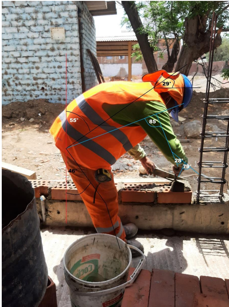
Figura 190: Asentado de ladrillo (REBA – T1), Consorcio Negrón, 2021.
