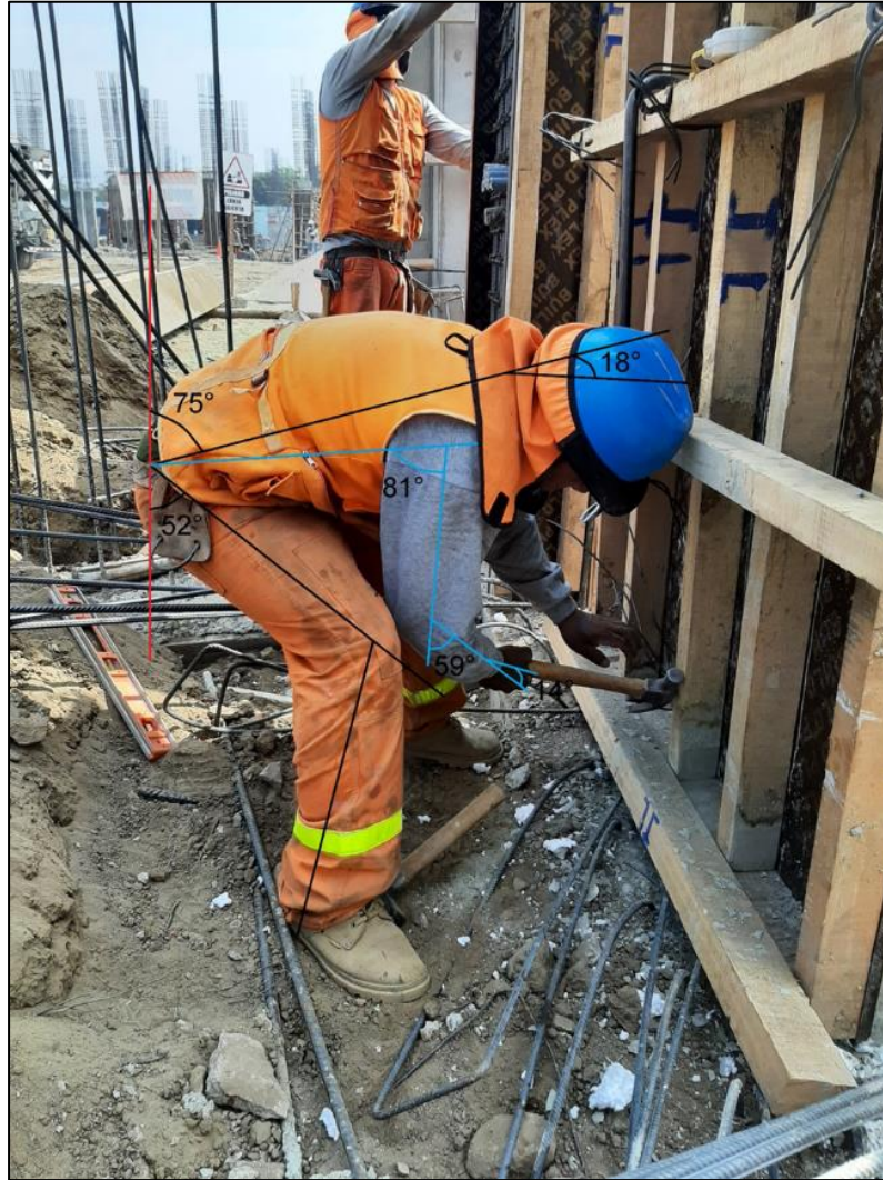
Figura 125: Encofrado de columnas (REBA – T2), Consorcio Negrón, 2021. Fuente: Elaboración propia.
