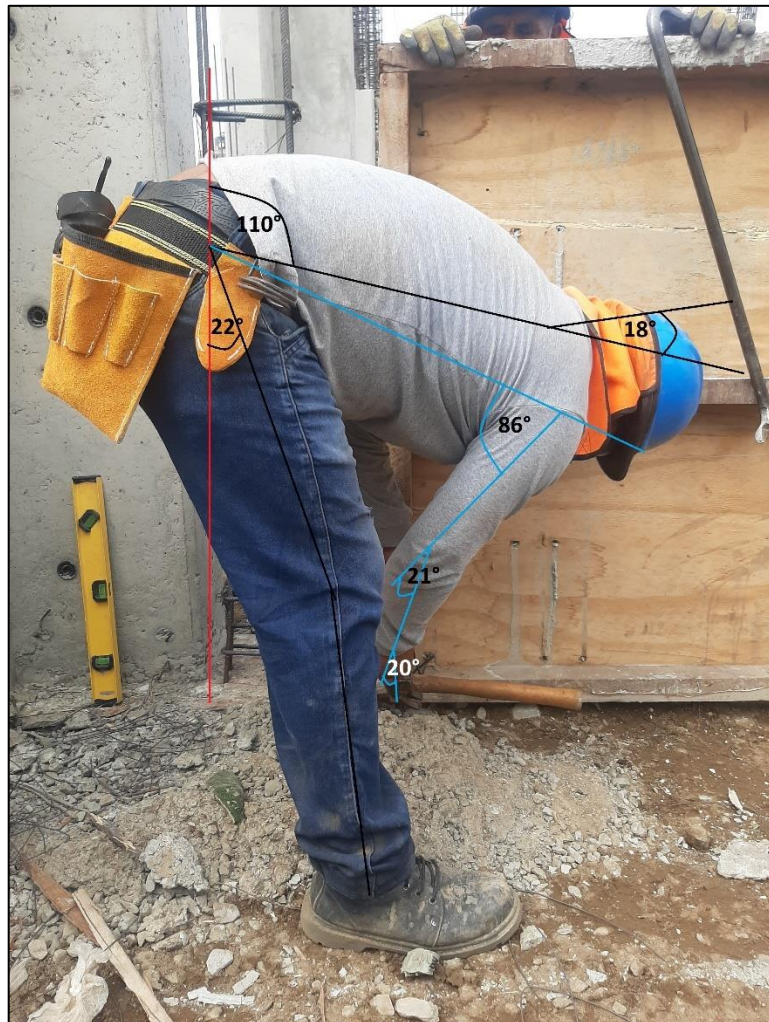
Figura 60: Encofrado de columnetas (RULA – T1), Consorcio Negrón, 2021.
