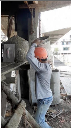
Figura 230: Levantamiento de destino – Ladrillo pastelero N2 (3)
