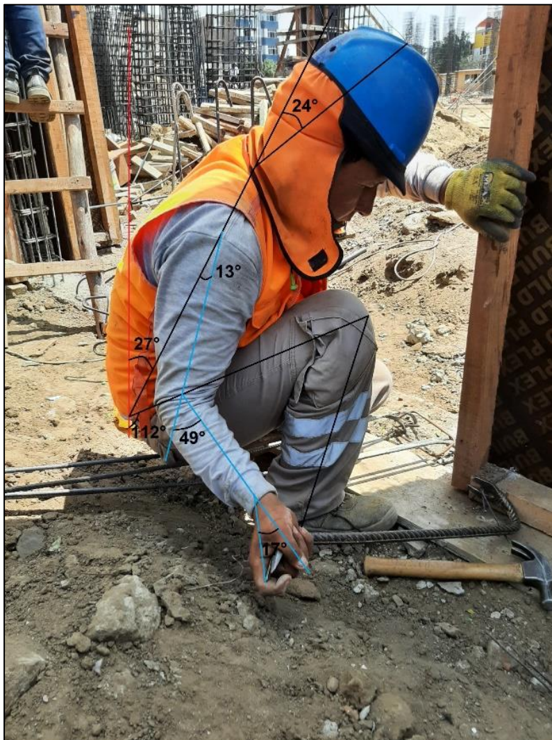
Figura 120: Encofrado de columnas (REBA – T1), Consorcio Negrón, 2021.
