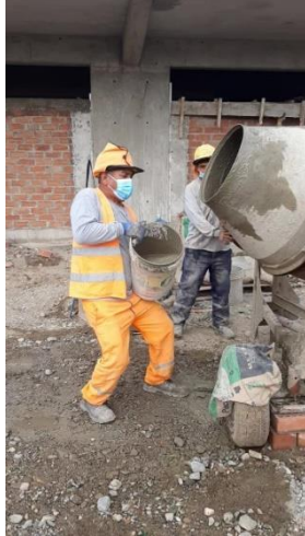
Figura 234: Levantamiento de origen – Vaciado de viguetas N4 (1)
