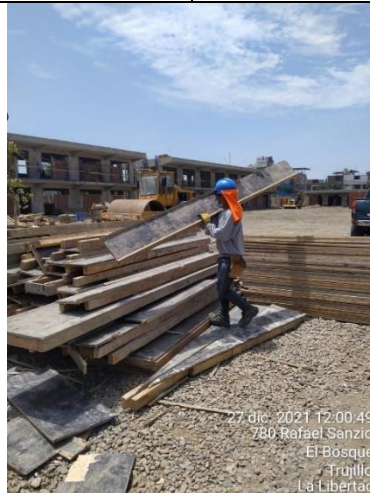
Figura 233: Levantamiento de destino – Desencofrado de vigas N3 (3)
