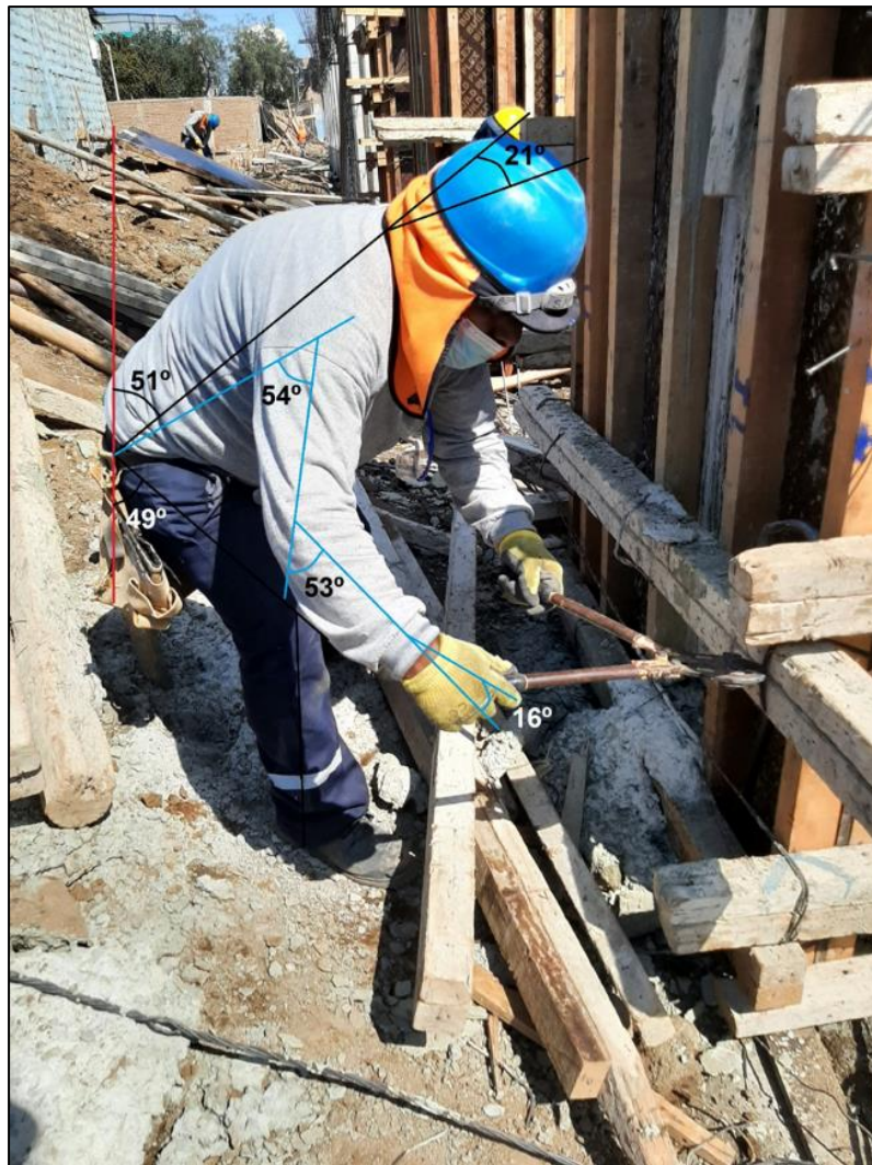
Figura 130: Desencofrado de columnas (REBA – T1), Consorcio Negrón, 2021.
