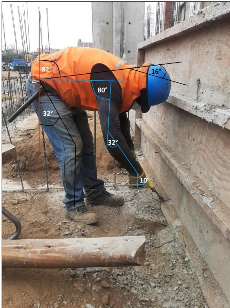
Figura 70: Desencofrado de columnetas (RULA – T1), Consorcio Negrón, 2021.
