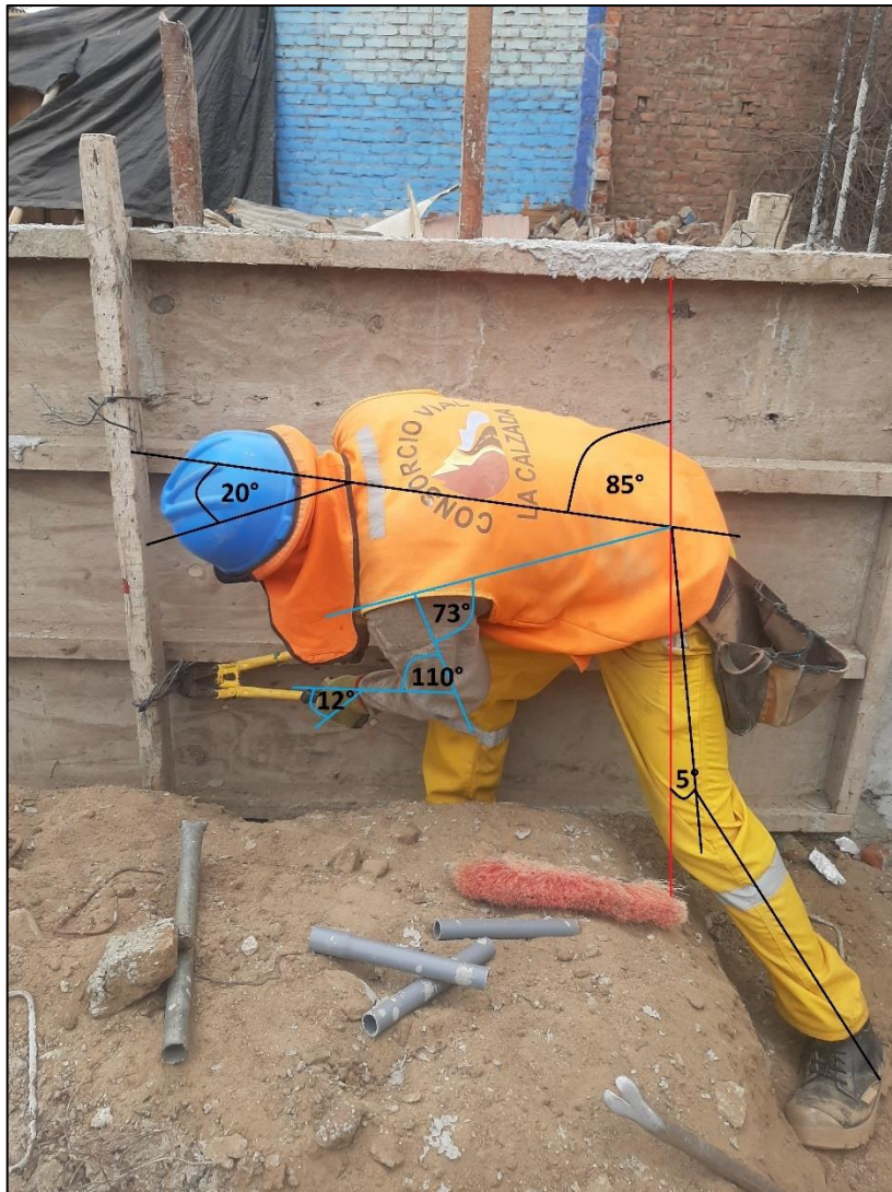
Figura 165: Desencofrado de columnetas (REBA – T2), Consorcio Negrón, 2021.
