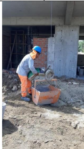
Figura 239: Levantamiento de destino – Vaciado de escaleras N5 (3) Fuente: Elaboración propia
