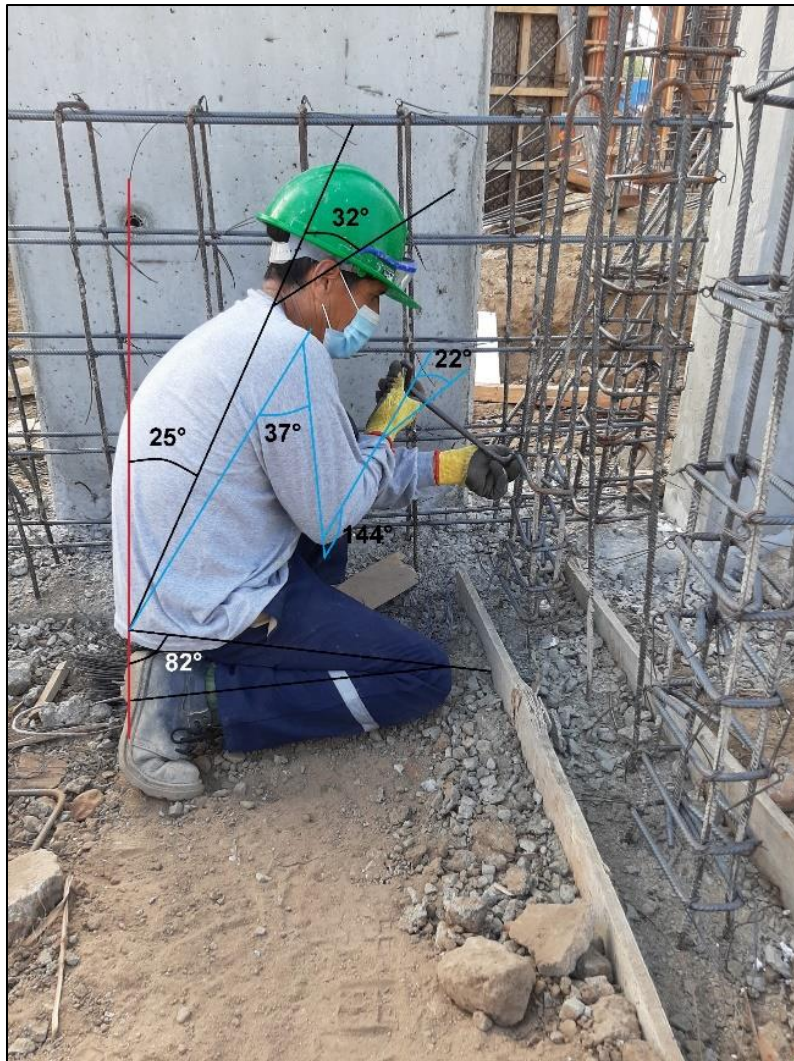
Figura 50: Armado de columnetas (RULA – T1), Consorcio Negrón, 2021.
