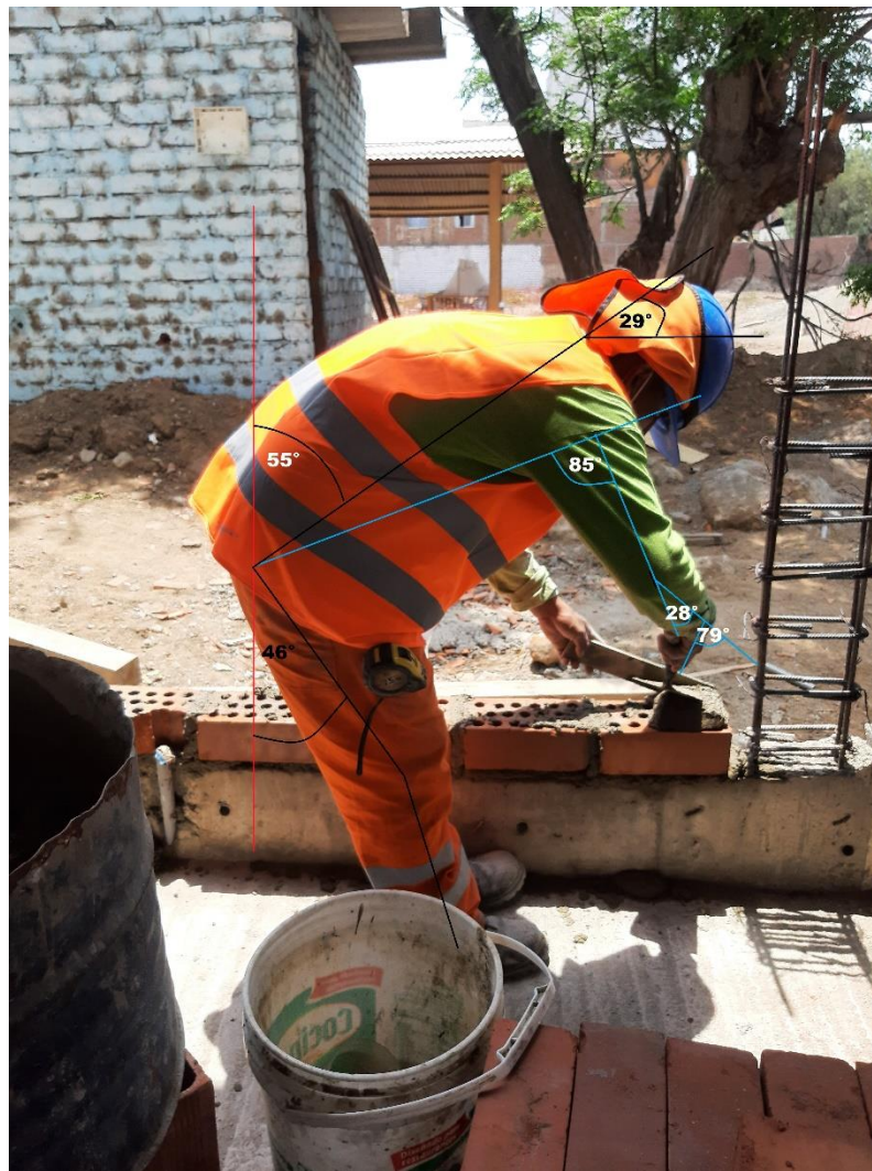
Figura 100: Asentado de ladrillo (RULA – T1), Consorcio Negrón, 2021.
