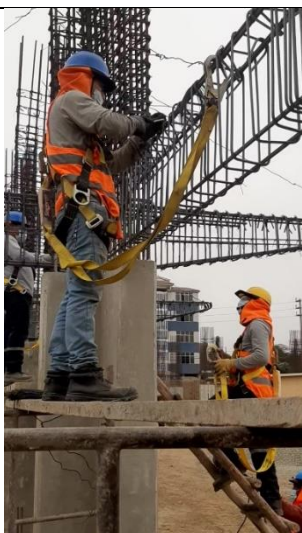
Figura 205: Armado de estructura de vigas - B1 (1)
