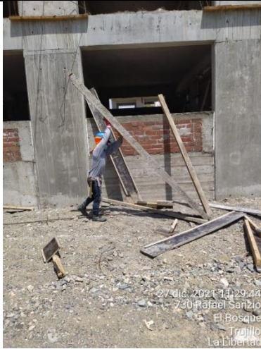
Figura 231: Levantamiento de origen – Desencofrado de vigas N3 (1)
