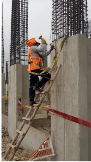
Figura 210: Picado de columnas - C1 (1)
