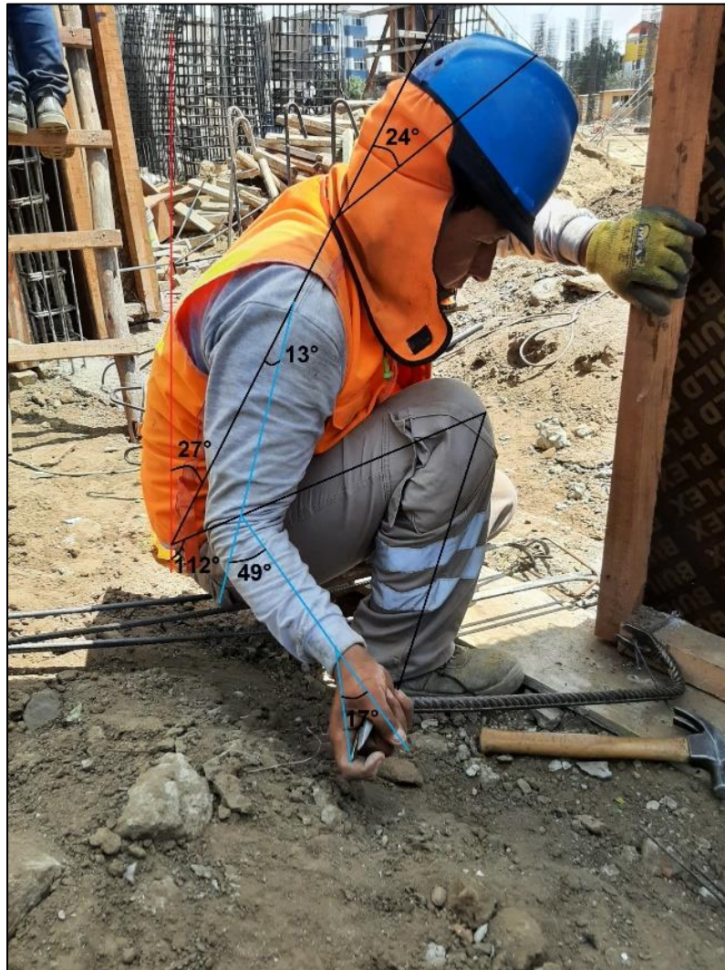
Figura 30: Encofrado de columnas (RULA – T1), Consorcio Negrón, 2021.
