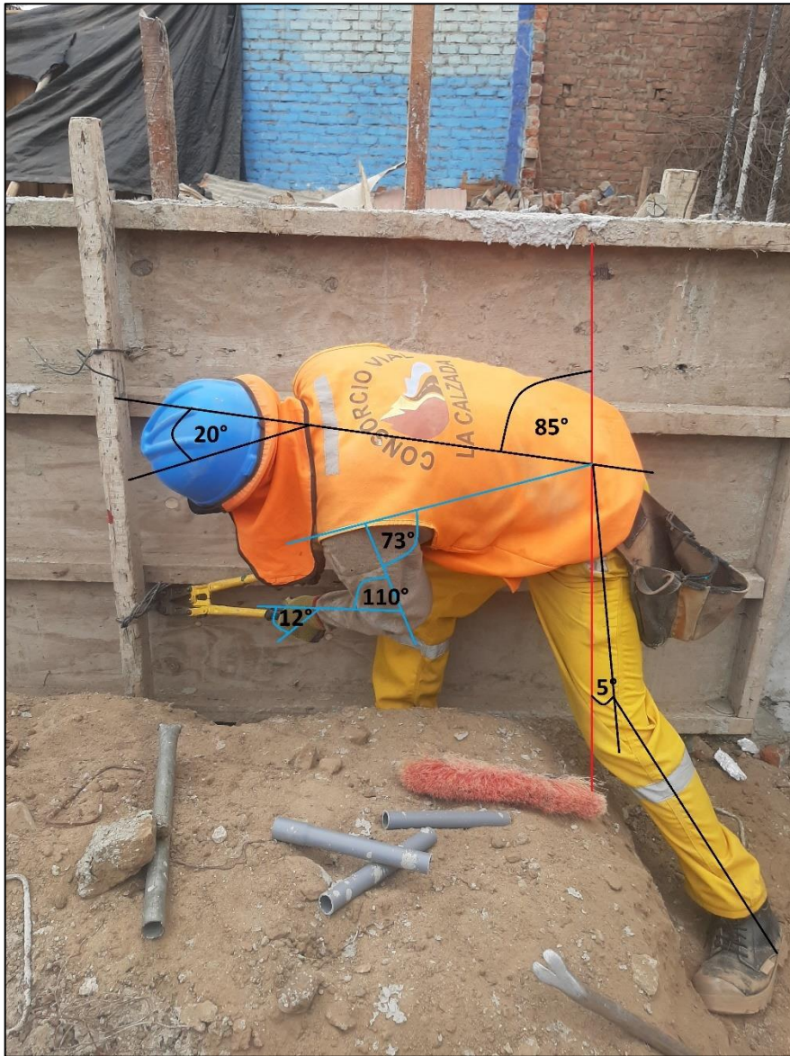
Figura 75: Desencofrado de columnetas (RULA – T2), Consorcio Negrón, 2021.
