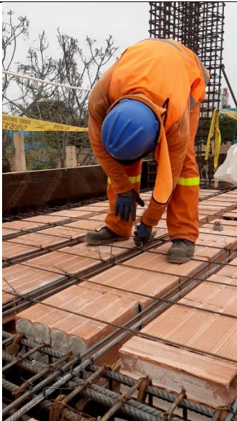
Figura 217: Armado de malla fina - D1 (3)
