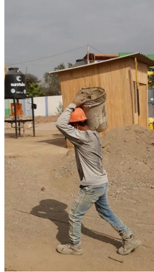
Figura 229: Levantamiento - Ladrillo pastelero N2 (2)
