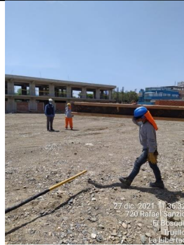
Figura 232: Levantamiento – Desencofrado de vigas N3 (2)
