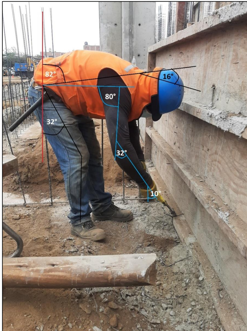
Figura 160: Desencofrado de columnetas (REBA – T1), Consorcio Negrón, 2021.
