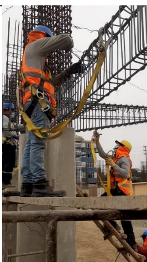
Figura 207: Armado de estructura de vigas - B1 (3)
