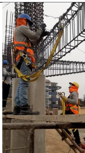
Figura 206: Armado de estructura de vigas - B1 (2)
