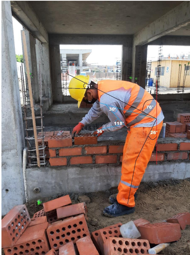
Figura 195: Asentado de ladrillo (REBA – T2), Consorcio Negrón, 2021.
