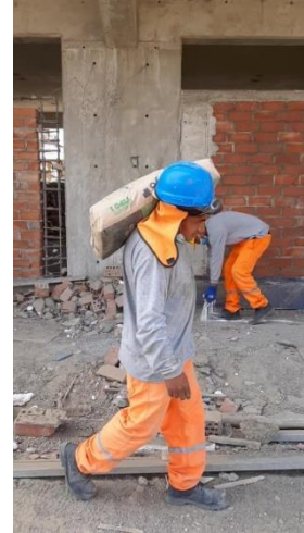
Figura 238: Levantamiento – Vaciado de escaleras N5 (2) Fuente: Elaboración propia
