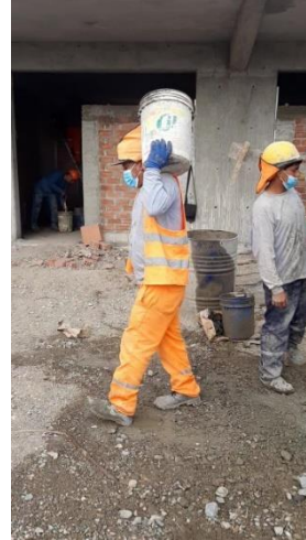
Figura 235: Levantamiento – Vaciado de viguetas N4 (2)
