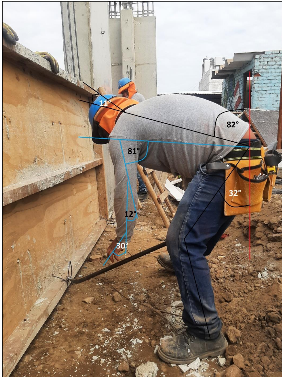
Figura 155: Encofrado de columnetas (REBA – T2), Consorcio Negrón, 2021.
