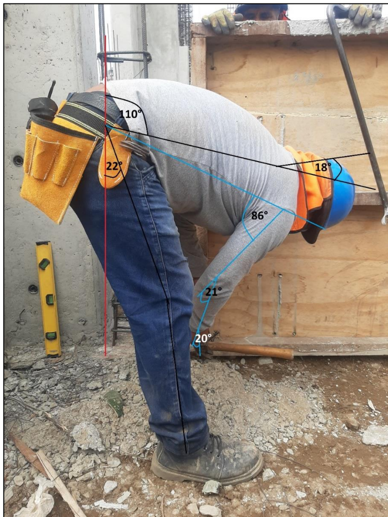
Figura 150: Encofrado de columnetas (REBA – T1), Consorcio Negrón, 2021.
