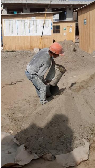
Figura 228: Levantamiento de origen – Ladrillo pastelero N2 (1)
