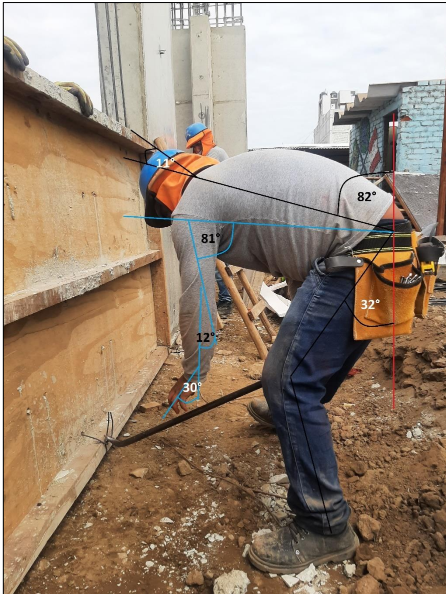
Figura 65: Encofrado de columnetas (RULA – T2), Consorcio Negrón, 2021.
