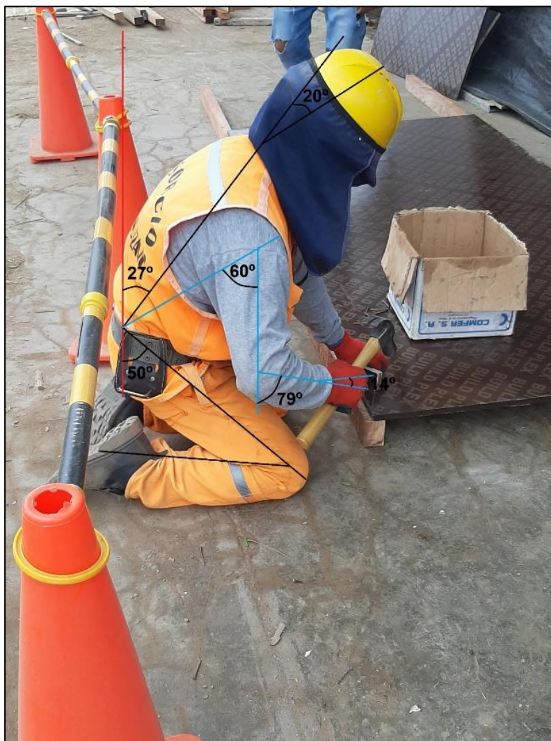
Figura 110: Armado de paneles para encofrar (REBA – T1), Consorcio Negrón, 2021.
