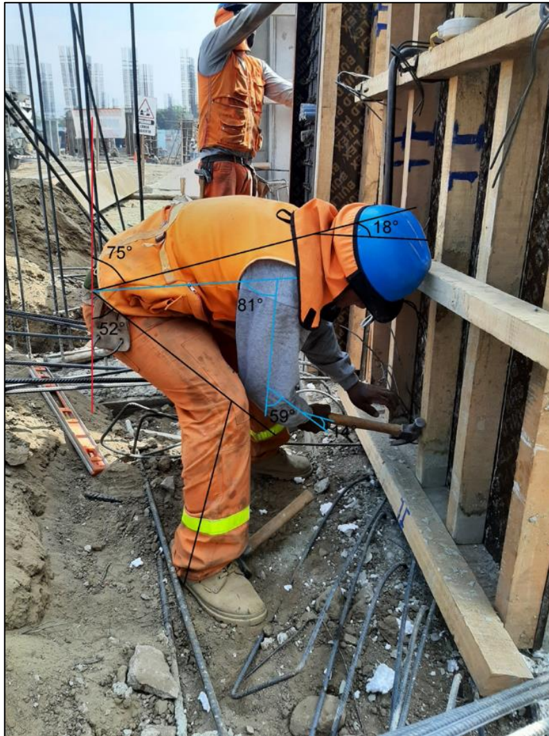
Figura 35: Encofrado de columnas (RULA – T2), Consorcio Negrón, 2021.
