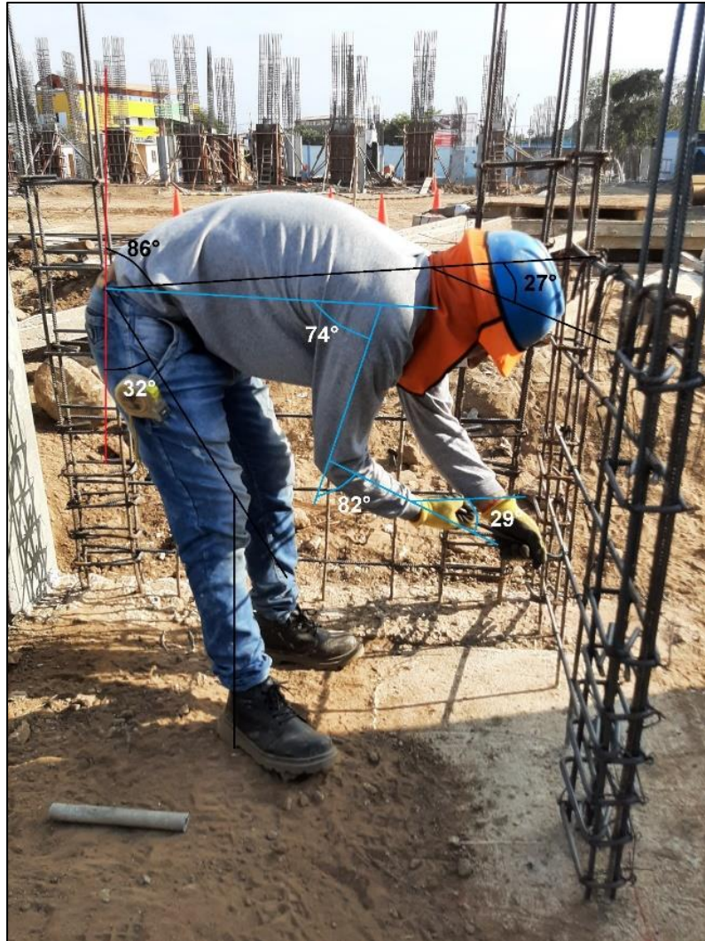
Figura 55: Armado de columnetas (RULA – T2), Consorcio Negrón, 2021.
