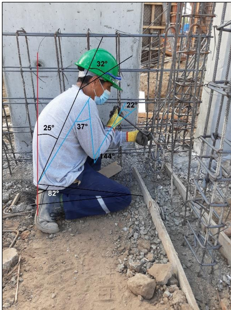
Figura 140: Armado de columnetas (REBA – T1), Consorcio Negrón, 2021.
