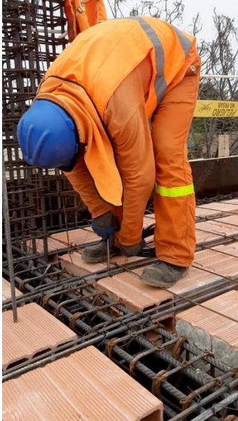
Figura 215: Armado de malla fina - D1 (1)
