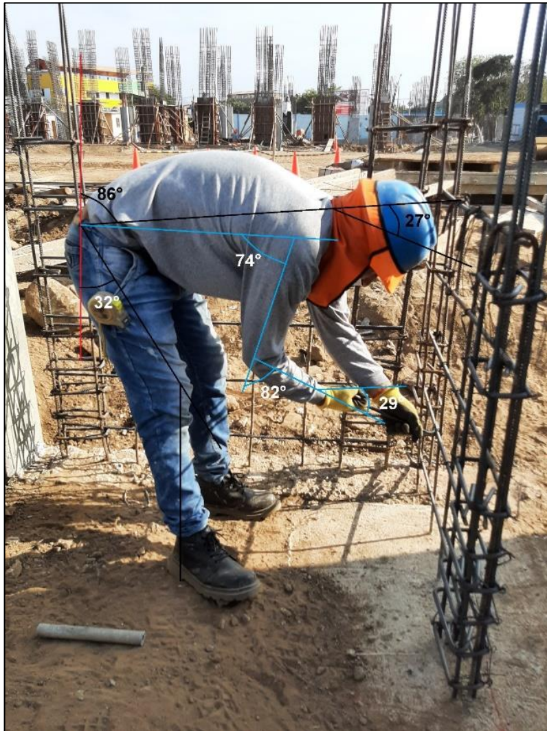
Figura 145: Armado de columnetas (REBA – T2), Consorcio Negrón, 2021.
