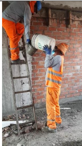
Figura 236: Levantamiento de destino – Vaciado de viguetas N4 (3)
