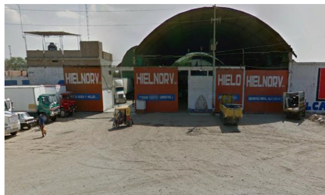
ILUSTRACIÓN 139: Fabrica de Hielo FUENTE: Google Earth Pro
