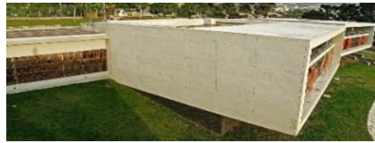
ILUSTRACIÓN 20: Muro blanco en todo el proyecto
