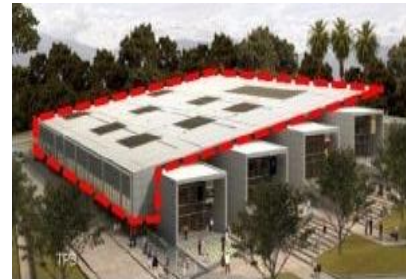
ILUSTRACIÓN 65: El techo es un elemento independiente
