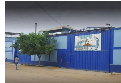
ILUSTRACIÓN 136: Planta de Prod. Hidrobiológico FUENTE: Google Earth Pro
