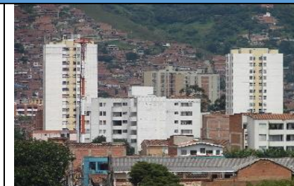
ILUSTRACIÓN 47: Edificaciones Residenciales Las construcciones vecinas son de carácter residencial.
