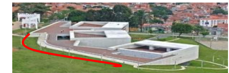
ILUSTRACIÓN 25: Muro de contención de gavión
