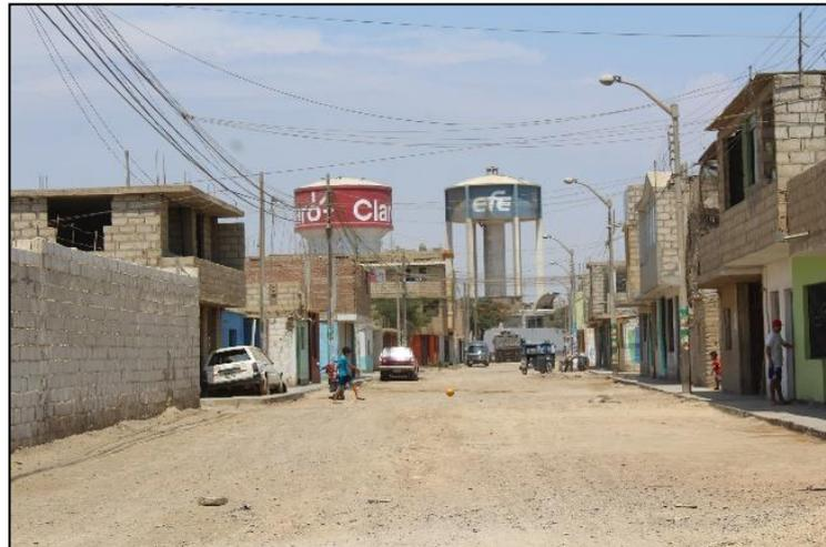
Figura 55. Psje. Vigil sin capa asfáltica y sin una red de aguas pluviales.
