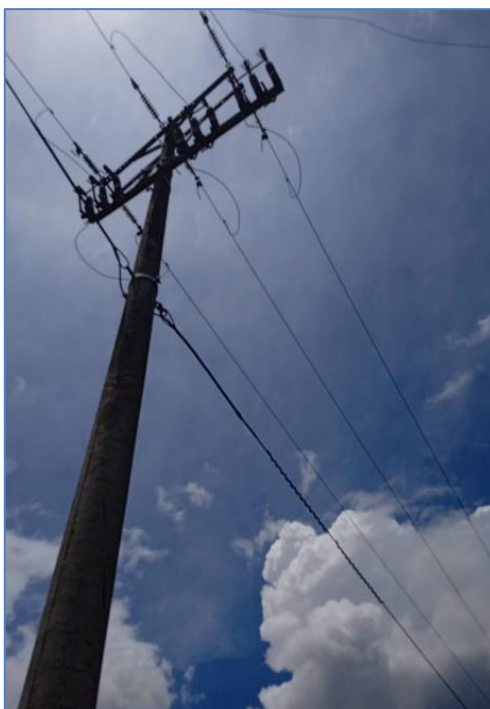
FIGURA 13: estructura de instalación de equipo de protección.
