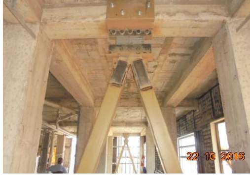
Figura 8. Implementación de disipadores SLB hotel Ceibo
