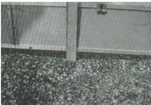
Figura 9. Ahuellamiento
