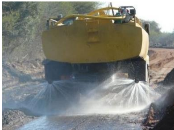
Figura 3. Humedecimiento de la subrasante.
