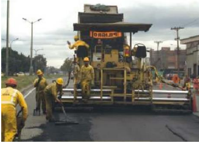
Figura 4. Pavimentadora o finisher
