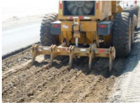
Figura 2. Escarificado de la sub rasante.
