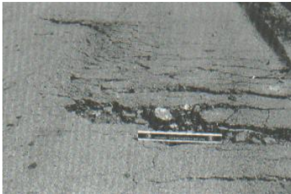
Figura 11. Grietas parabólicas
