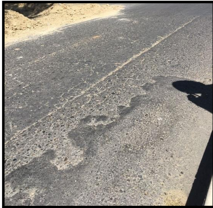
Figura 28: Piel de cocodrilo de severidad media.
