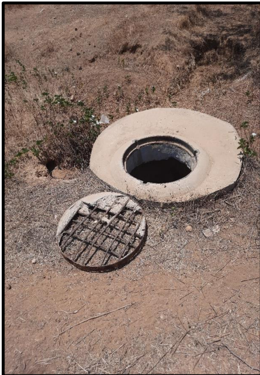
Fotografía N° 20: Estado de buzones de válvulas.
