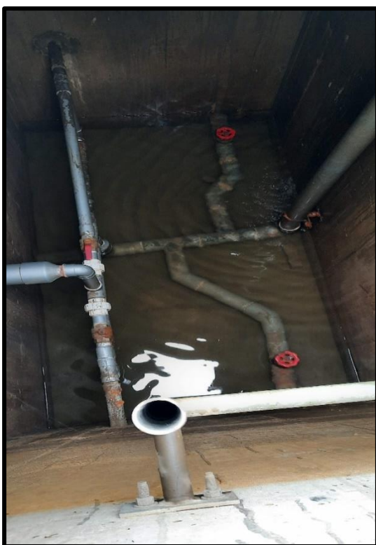
Fotografía N° 10: Fuga de Agua en Válvulas de PTAP.
