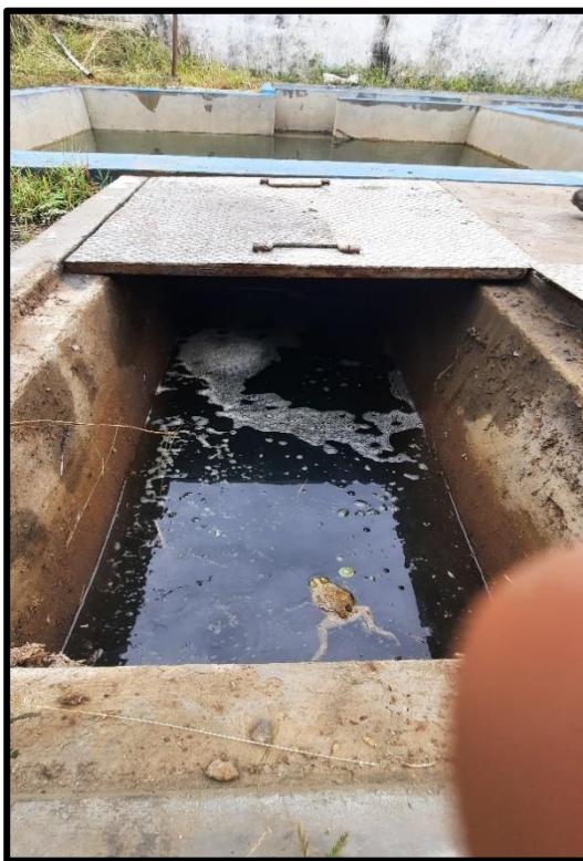
Fotografía N° 10: Fuga de Agua en Válvulas de PTAP.
