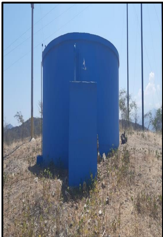
Fotografía N° 16: Reservorio de distribución (volumen de 100 m3).
