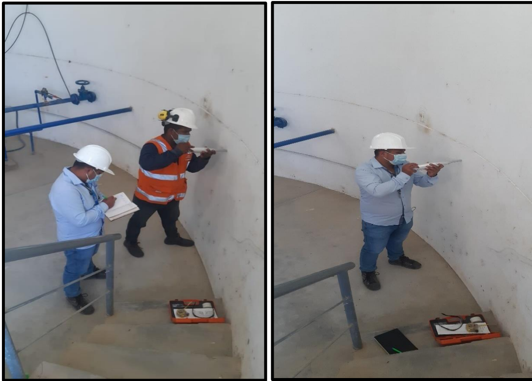
Fotografía N° 13: Realización del ensayo de esclerometría en la pared de la estación de bombeo.
