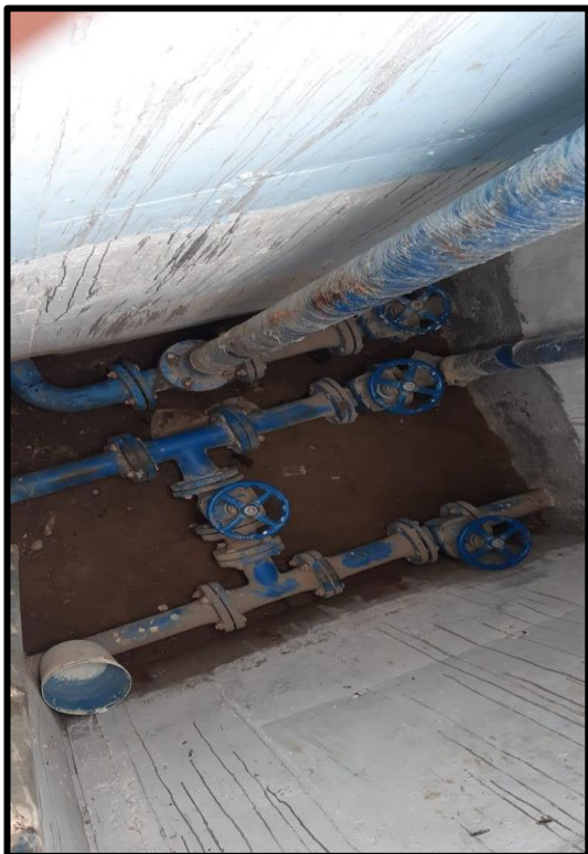
Fotografía N° 18: Humedad en caja de válvulas de Reservorio
