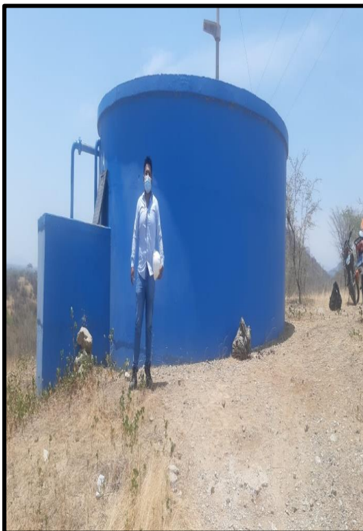
Fotografía N° 16: Reservorio de distribución (volumen de 100 m3).
