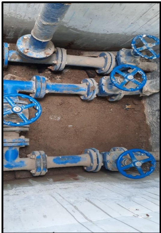
Fotografía N° 18: Humedad en caja de válvulas de Reservorio
