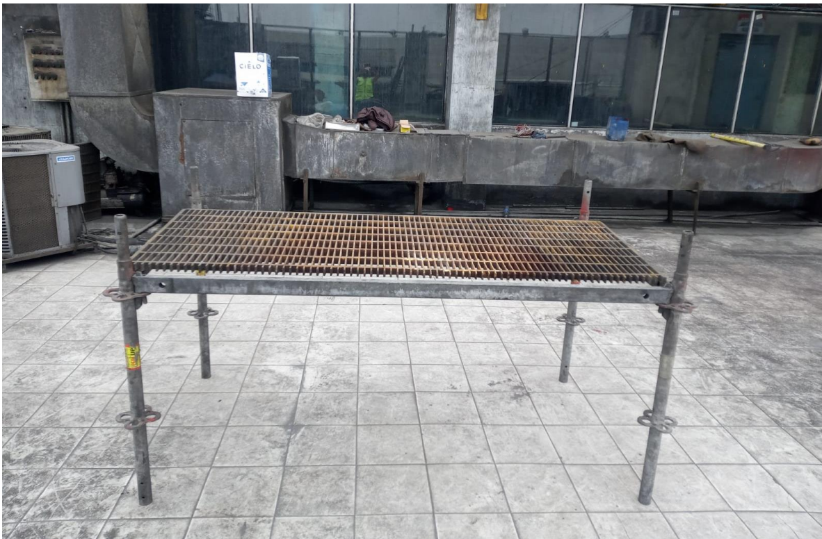
Figura 31: Construcción de la mesa regulable
