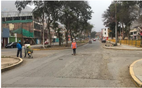
Foto 5. Agrietamiento en bloque
