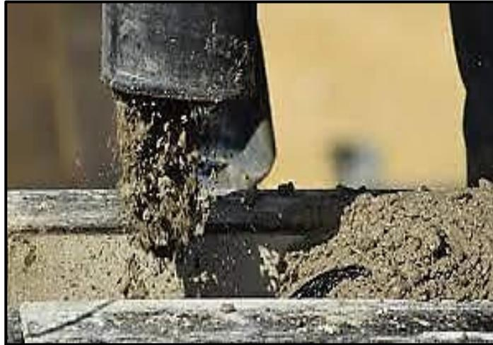
*Figura 3. Segregación del concreto*
