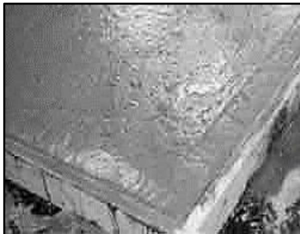
*Figura 4. Exudación del Concreto.*
