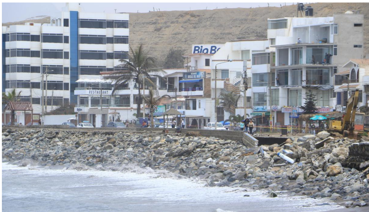
Figura 7. Erosión total del Balneario de Huanchaco en la actualidad
