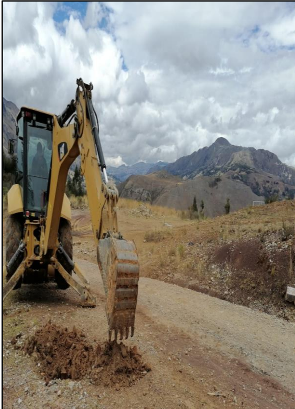
C - N°5: Excavación de calicata y muestreo.
