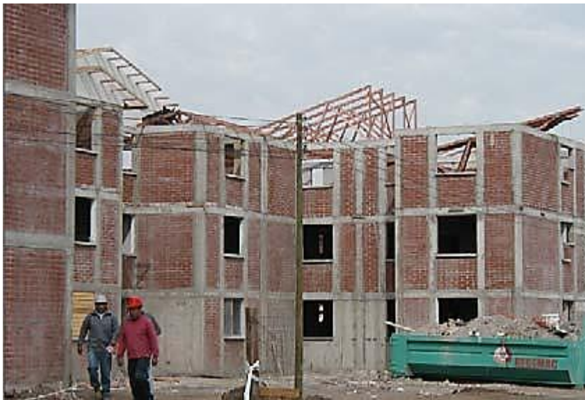
Figura 3. Muros de albañilería confinada. Fuente (San Bartolome, 2019).
