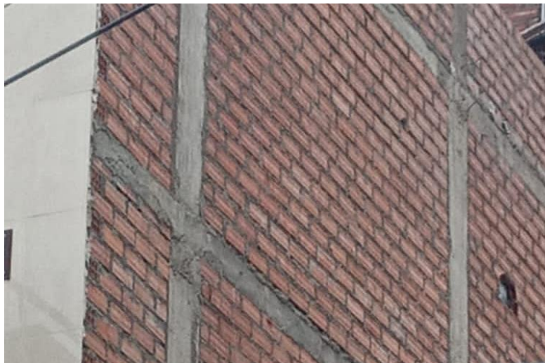
Figura 2. Se muestra los muros portantes a base de ladrillo panderetas. Fuente (elaboración propia).
