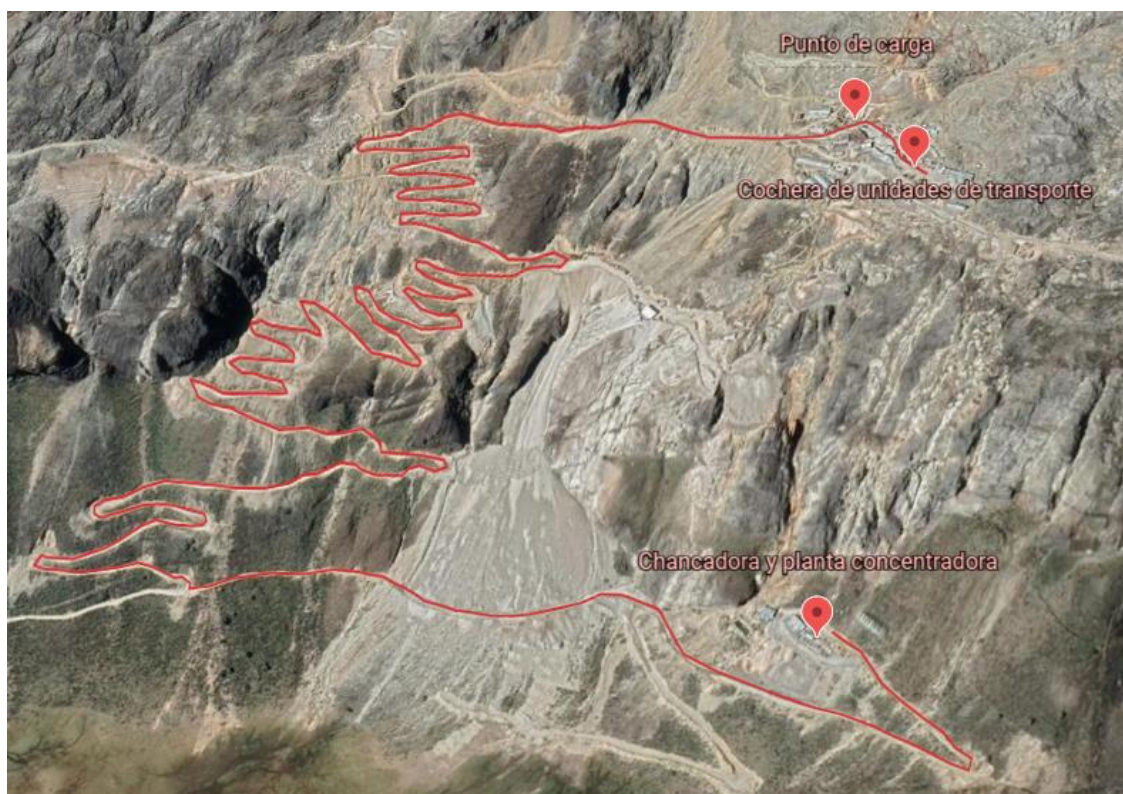
Figura 1. Vista de noreste a suroeste del recorrido de los vehículos.
