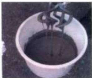
Mezclar **BUSTER** con agua limpia y con un agitador hasta lograr completa homogeneidad. La masa debe ser uniforme y sin grumos.
