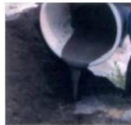
Verter el producto en el interior de los orificios. Esta operación debe realizarse dentro de los 15 min siguientes al mezclado.
