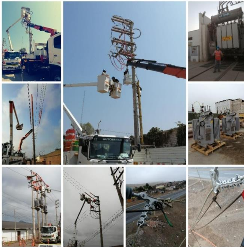
Figura 5. Trabajos Realizados por la Empresa Cobra.
