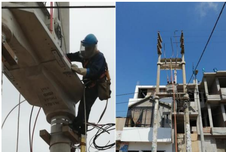
Figura 4. Trabajos realizados por la empresa Cobra.
