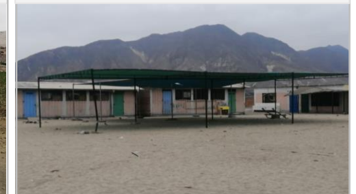
Subindicador – Equipamientos urbanos
