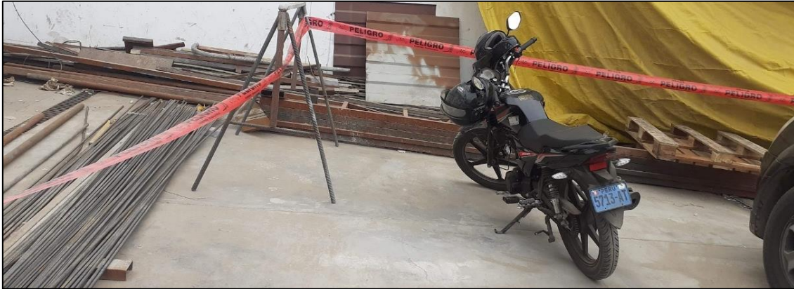
Figura 57: Indicador de prevención de seguridad.
