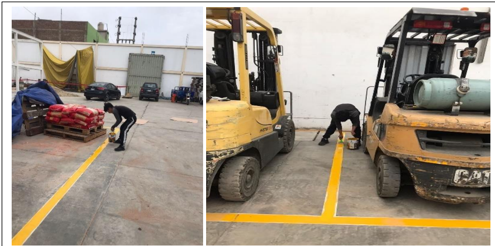
Figura 51: Señalización de suelo del área parqueo de motos y montacargas.
