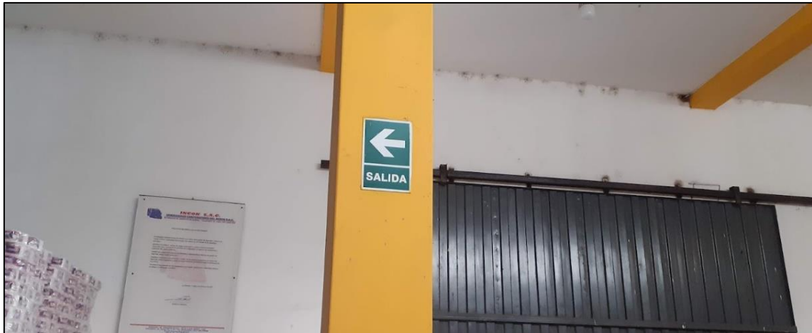
Figura 55: Indicador de salida de emergencia.
