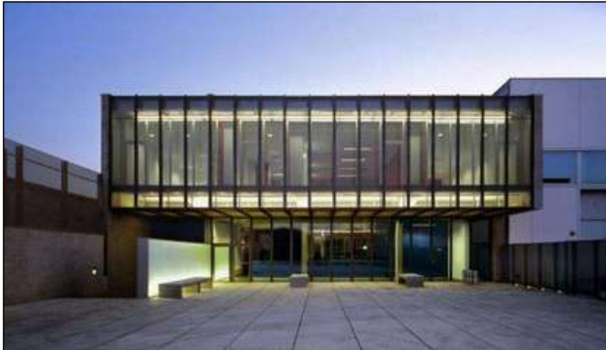
Figura 19. Vista del Centro de Emergencia en Alboraya. Vista frontal del Centro de Emergencia en Alboraya. Fuente ( Vera, et al., 2013).
