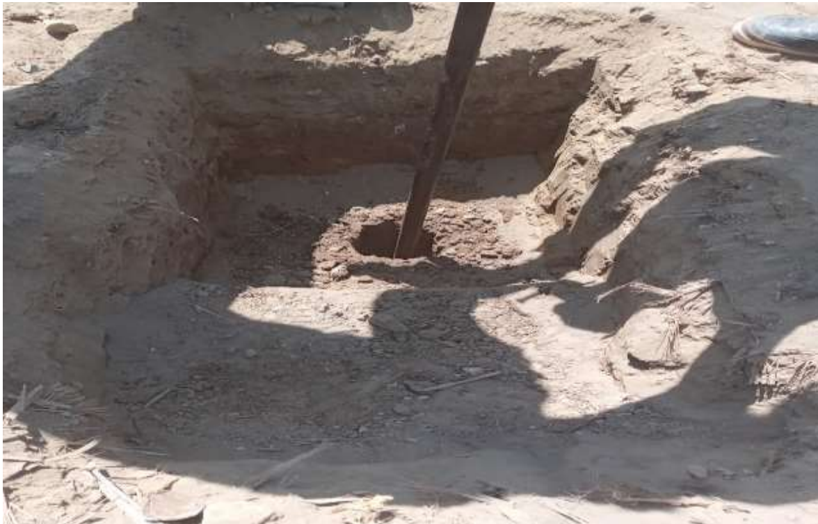
Figura 37: Excavación de calicata N° 01 - carretera Collud- Ventarrón, 2021.
