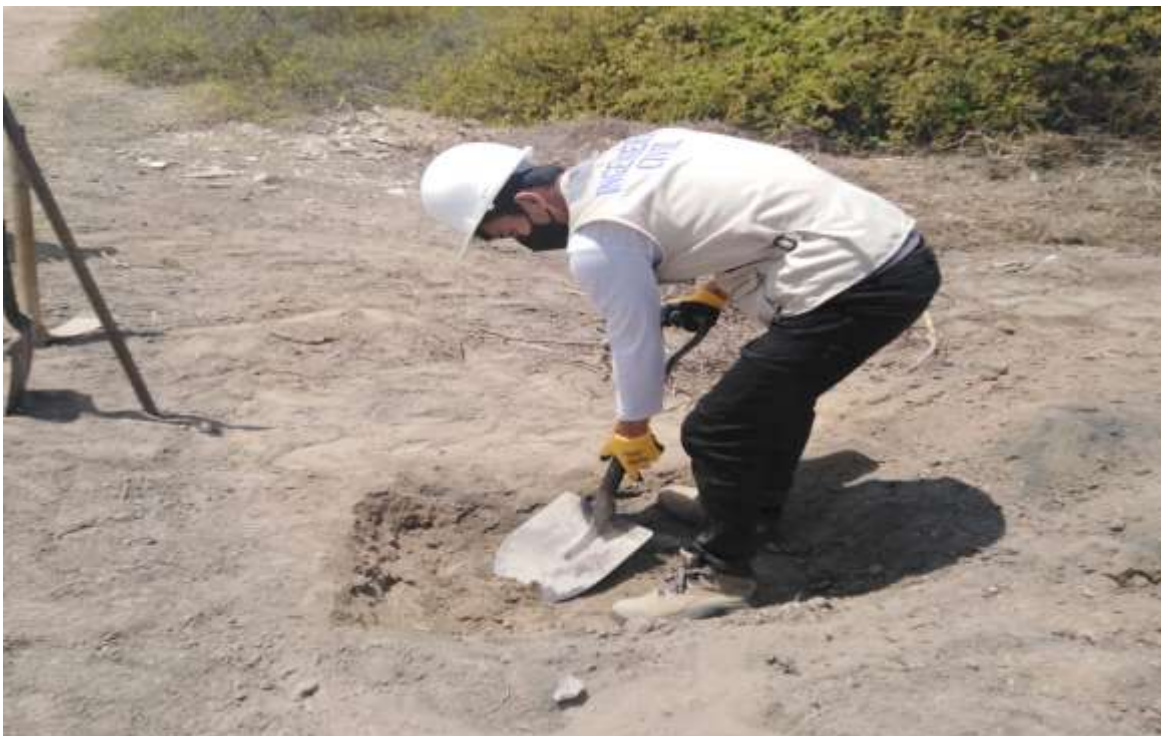
Figura 40: Excavación de calicata N° 02 - carretera Collud- Ventarrón, 2021.
