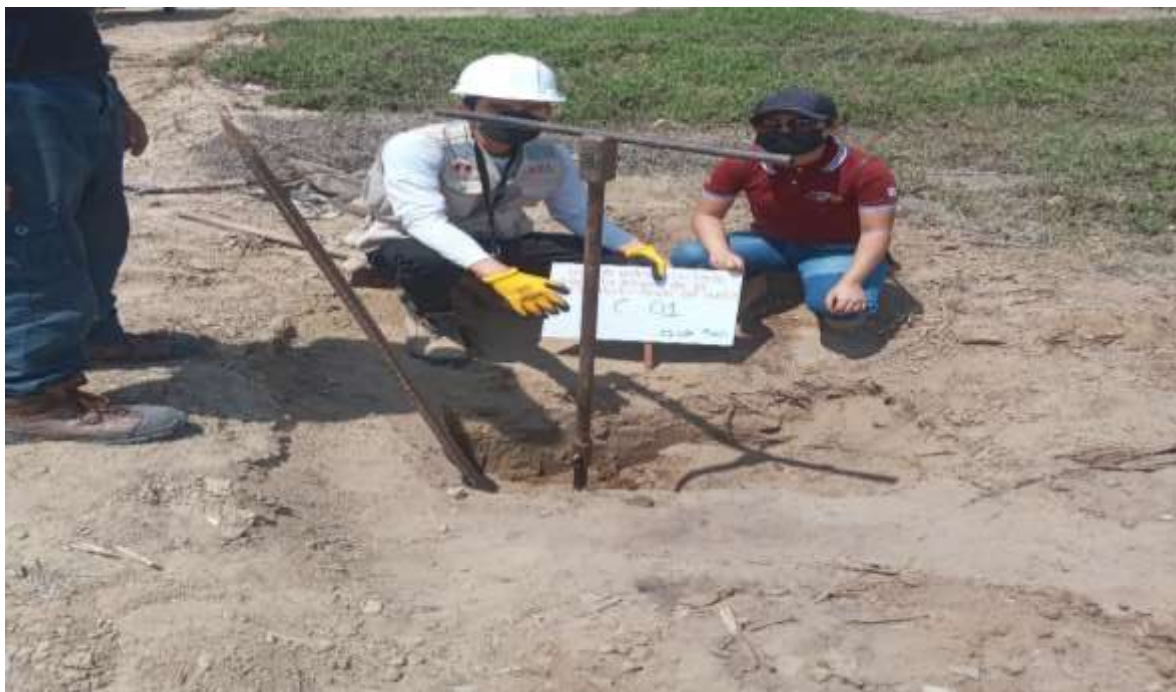
Figura 38: Excavación de calicata N°1- 11 de setiembre 2021.
