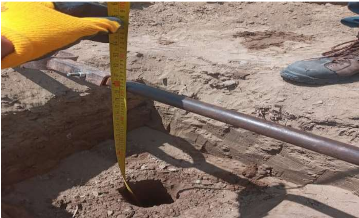
Figura 39: Verificación de profundidad de la calicata N°1 carretera Collud-Ventarrón, 2021.
