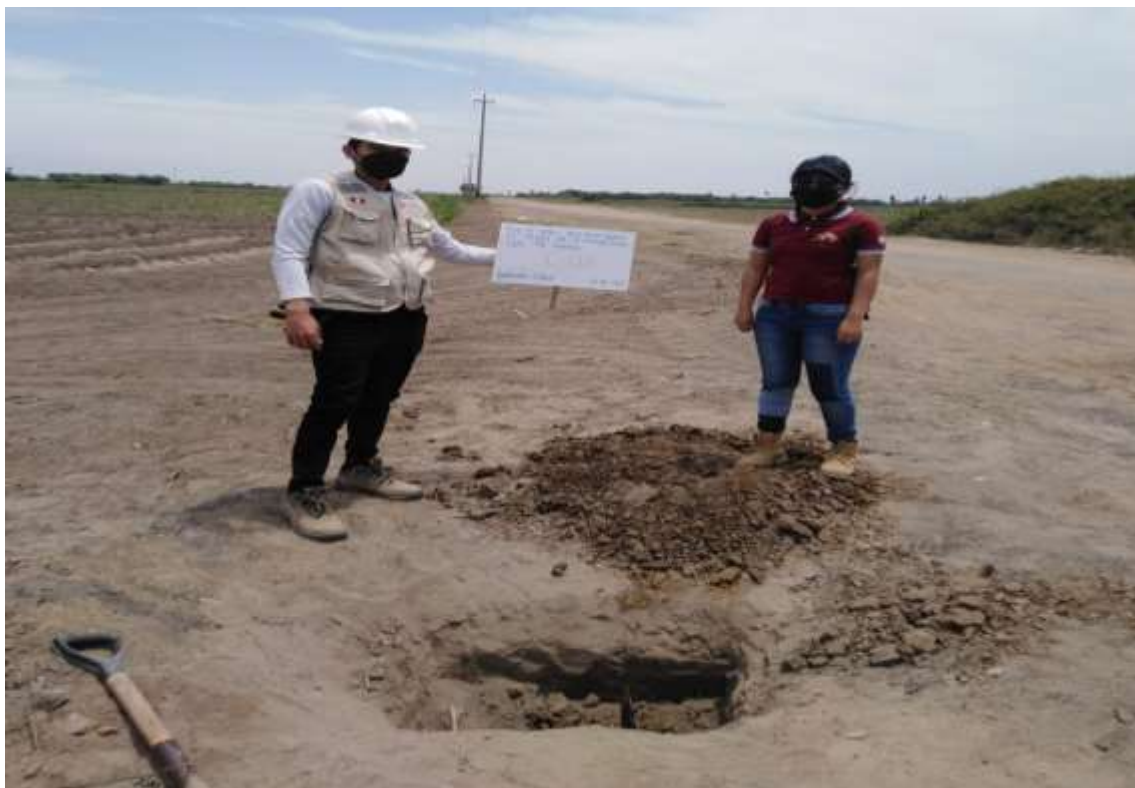
Figura 41: Excavación de calicata N° 02 - carretera Collud- Ventarrón, 2021.
