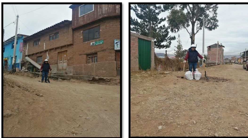
Figura 1. Realidad actual de la vía calle Ciro Alegría.
