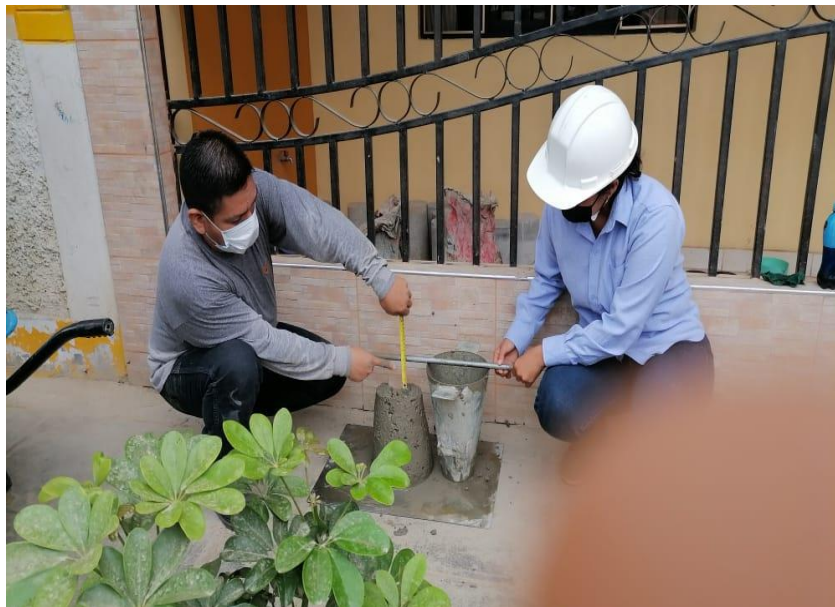
Figura 31. Detalle de la medición del asentamiento (slump)
