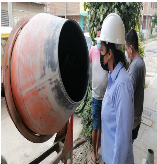
Figura 34. Verificando el trompo de mezclado
