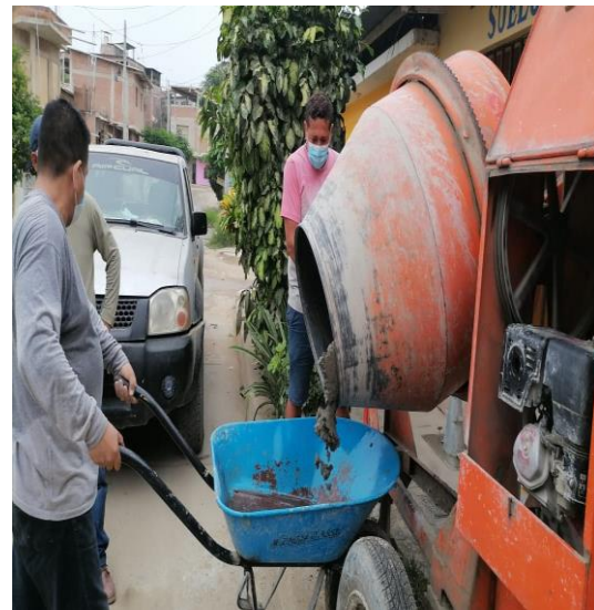
Figura 35. vaciado del concreto a la carretilla
