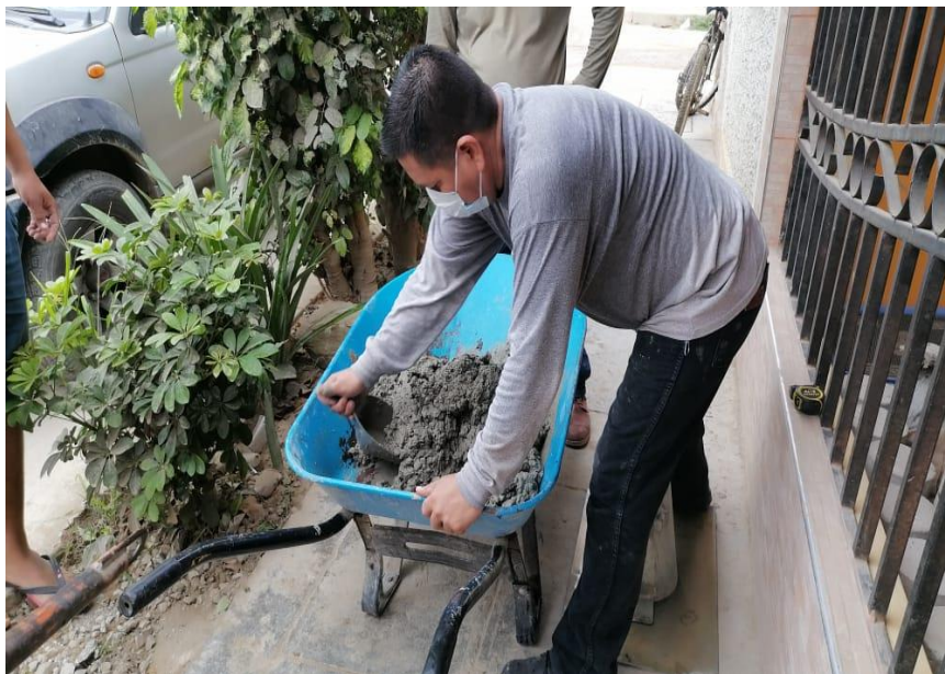
Figura 28. Mezclando el concreto
