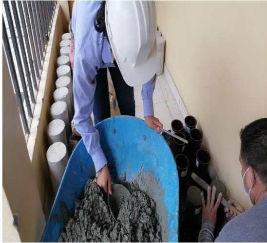
Figura 36. Batido del concreto previo al llenado
