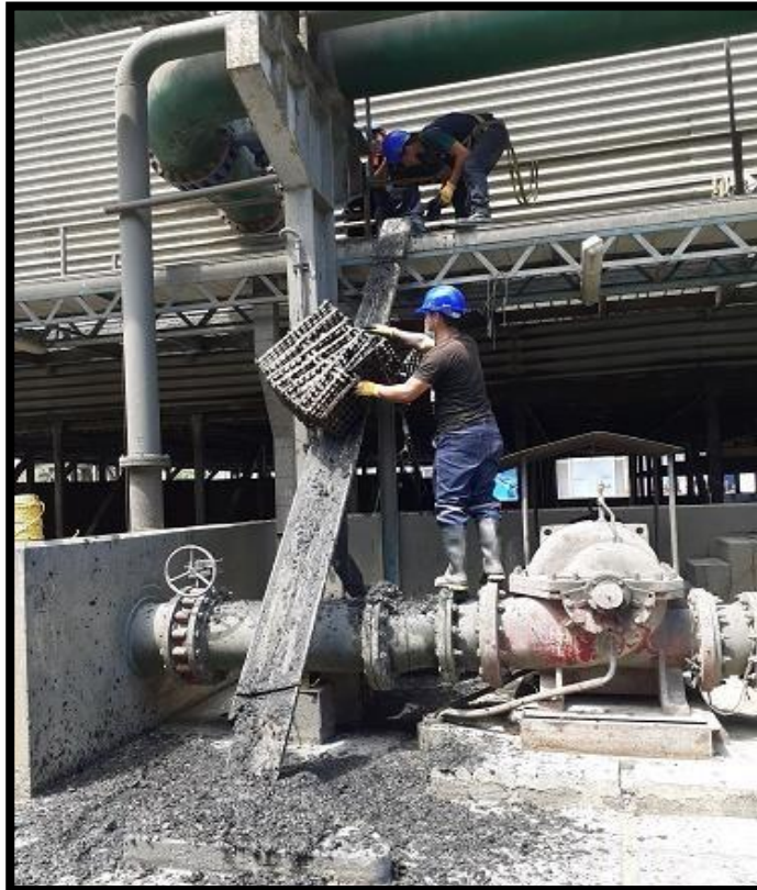
Desmontaje de relleno de propileno
