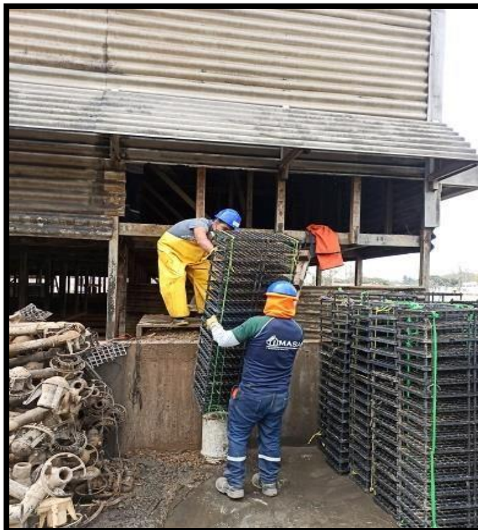
Rellenos limpios montando a torre
