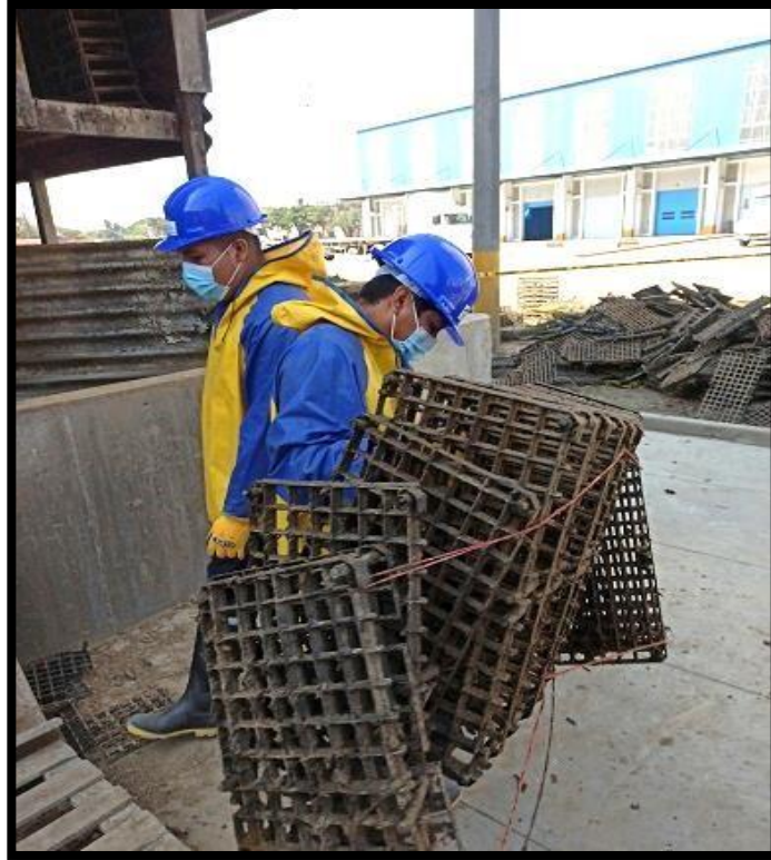
Traslado de rellenos de propileno
