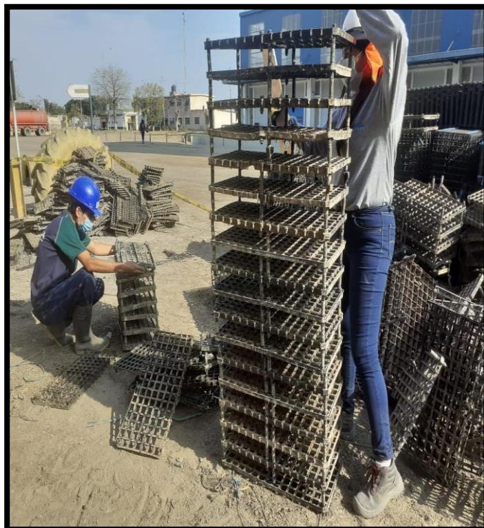
Armado de relleno de propileno
